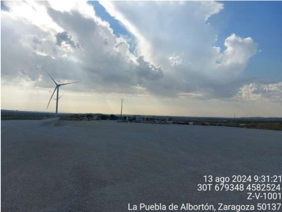
Imagen 1. Estado actual de la campa de acopio de obra civil.
