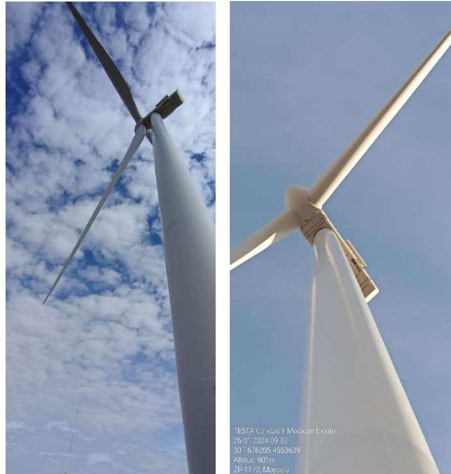
Fotografías 1 a 2: Barquillas de los aerogeneradores sin derrames de aceite
