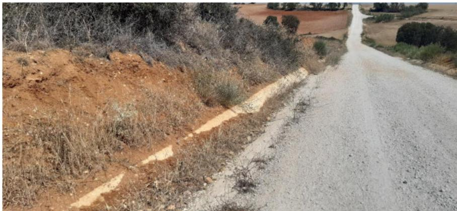
Imagen de la cuneta del vial de acceso a CNC-01 con afección de drenaje.
