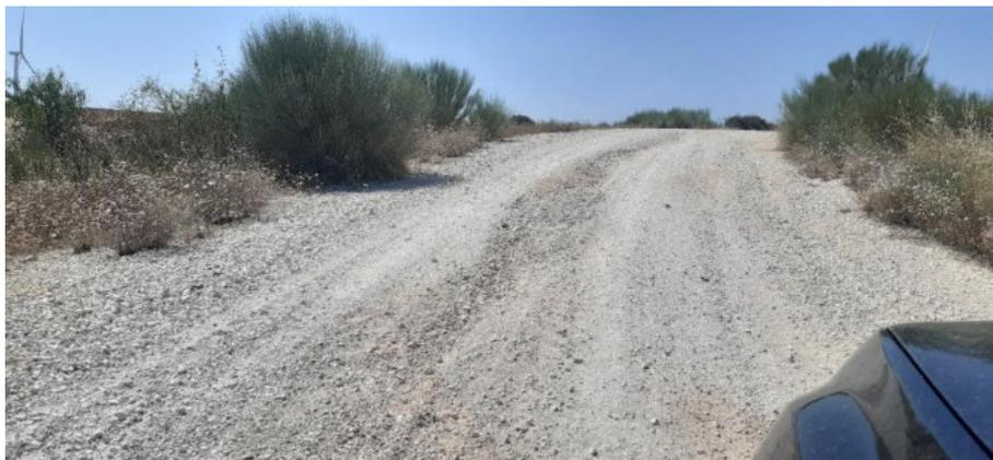
Imagen de la erosión hídrica en el vial de acceso a CNC-05.
