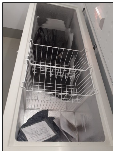
Fotografía 1. Arcón congelador del parque eólico
