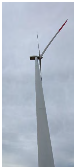
Fotografías 3. Estado aerogeneradores
