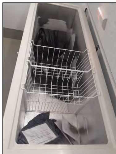
Fotografía 1. Arcón congelador del parque eólico
