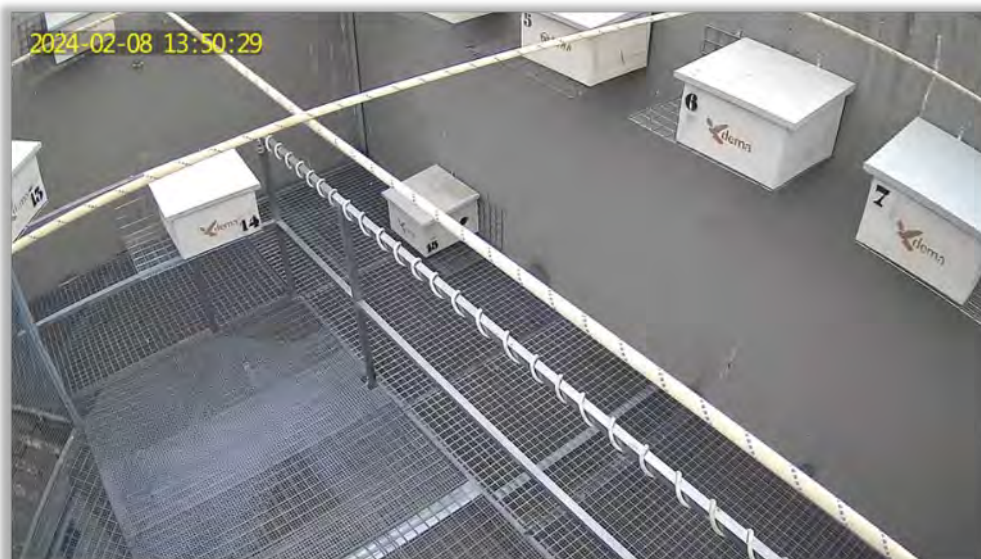
Foto 2. Nuevas infraestructuras ya instaladas
