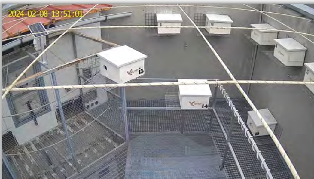
Foto 4. Nuevos nidos instalados. Se aprecia también la superficie de la nueva planta totalmente diáfana
