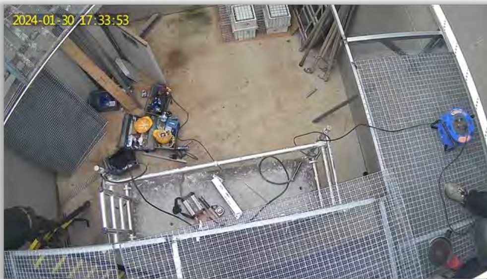
Foto 1. Instalación de la pasarela y malla de seguridad
