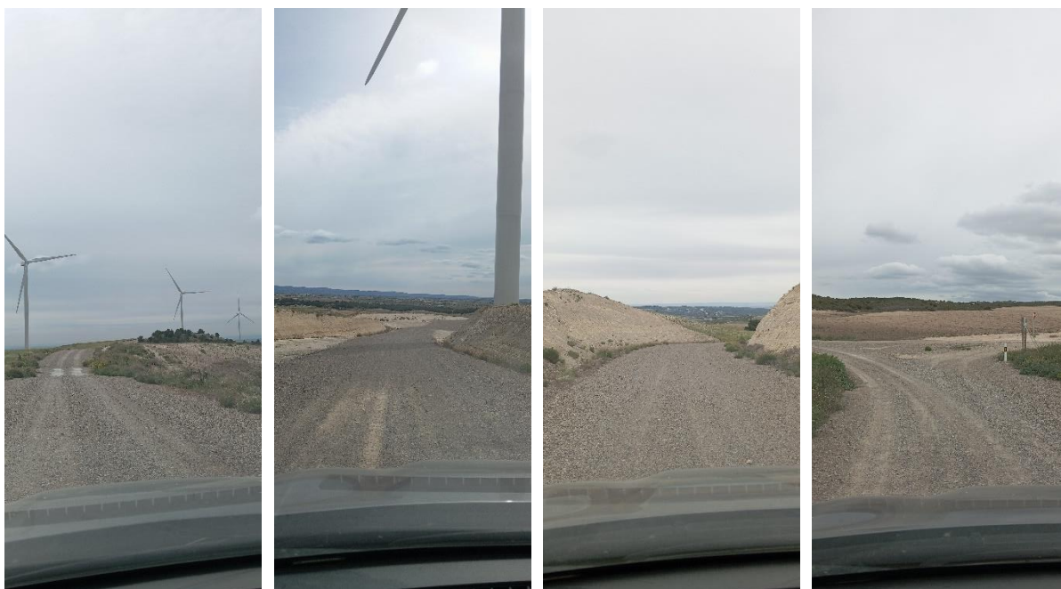
Fotografías 4 a 7: Estado de caminos y viales
