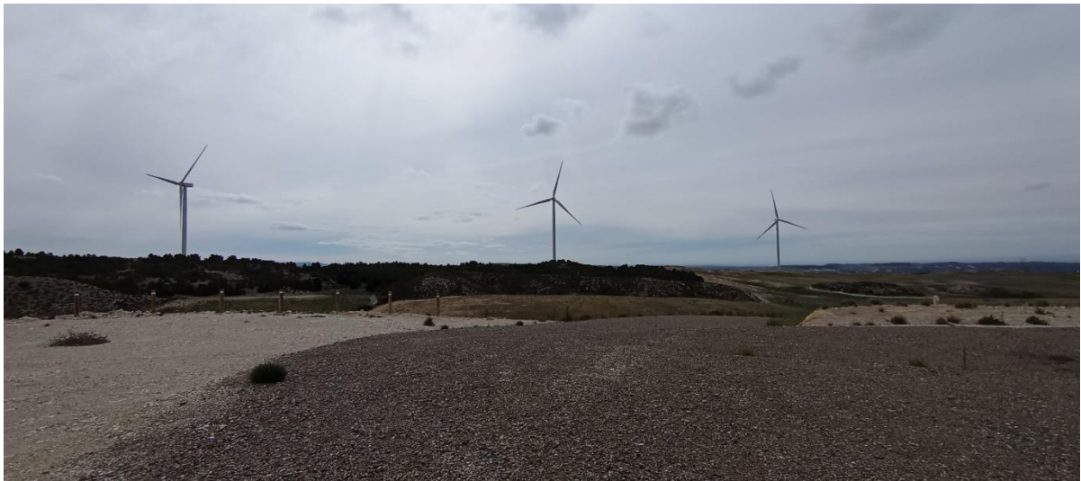
Fotografías 1 y 2: Visibilidad del parque eólico
