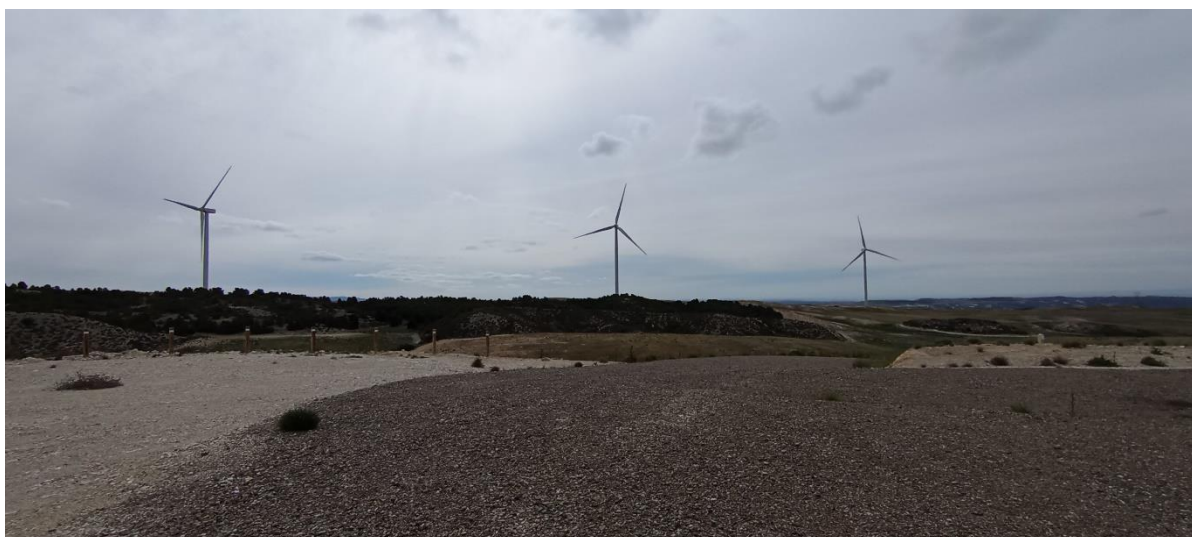
Fotografías 1 y 2: Visibilidad del parque eólico
