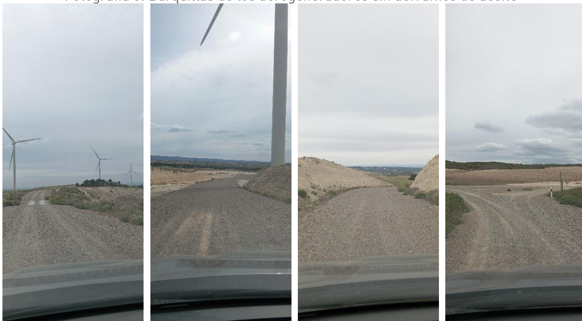
Fotografías 4 a 7: Estado de caminos y viales
