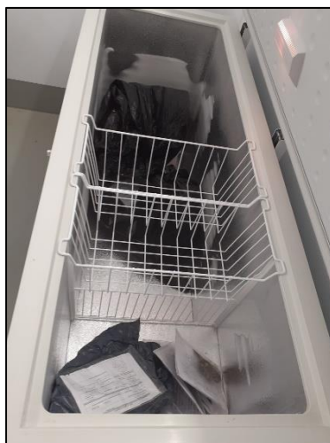
Fotografía 1. Arcón congelador del parque eólico
