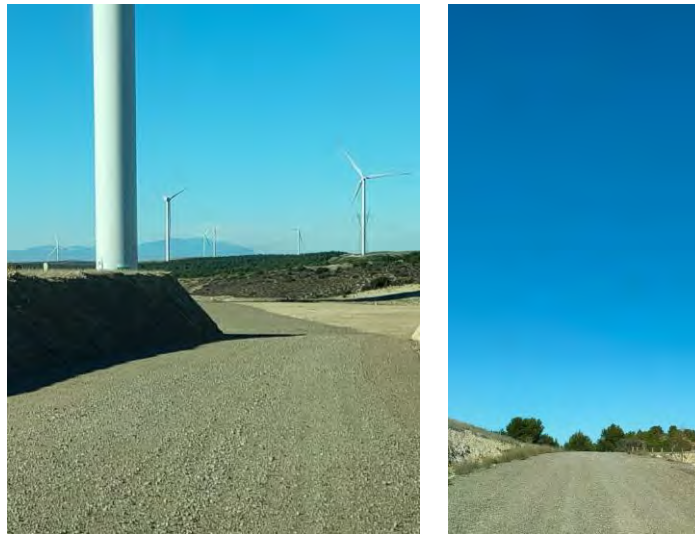
Fotografías 4 y 5: Estado de los caminos y viales
