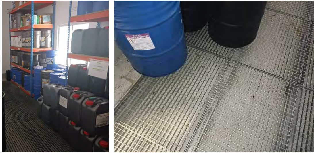
Fotografías 10 y 11: Almacén de Residuos Peligrosos y bidones sobre rejilla de contención
