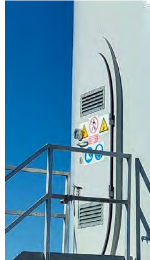
Fotografía 8: Señalización de las torres de los aerogeneradores
