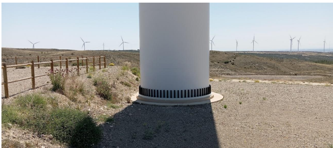
Fotografías 11 y 12: Bases de las torres de los aerogeneradores
