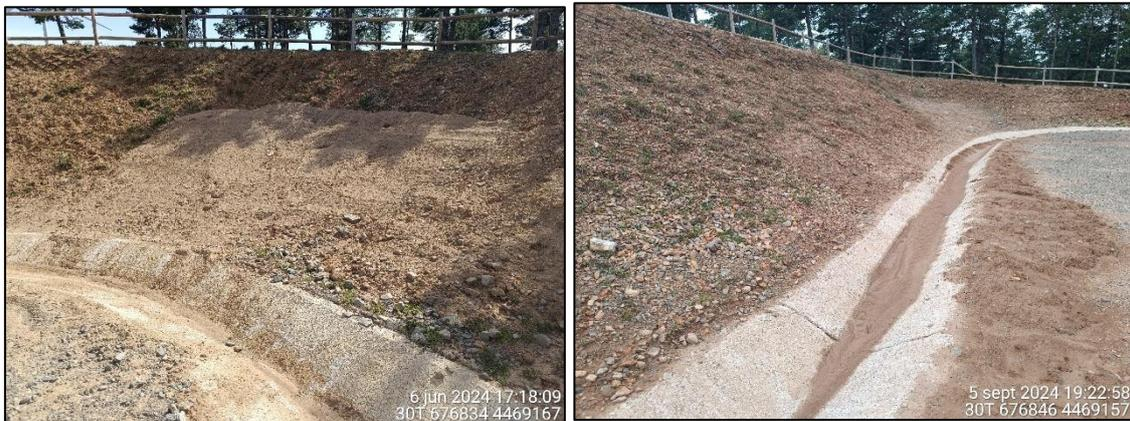
Figura 14: Cunetas del aerogenerador APE-05 en mayo (izda) y septiembre (dcha)
