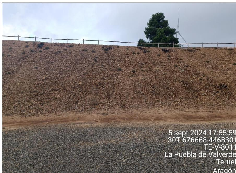
Figura 15: Estado de los taludes, con revegetación natural muy tímida y las plantas de la hidrosiembra secas.
