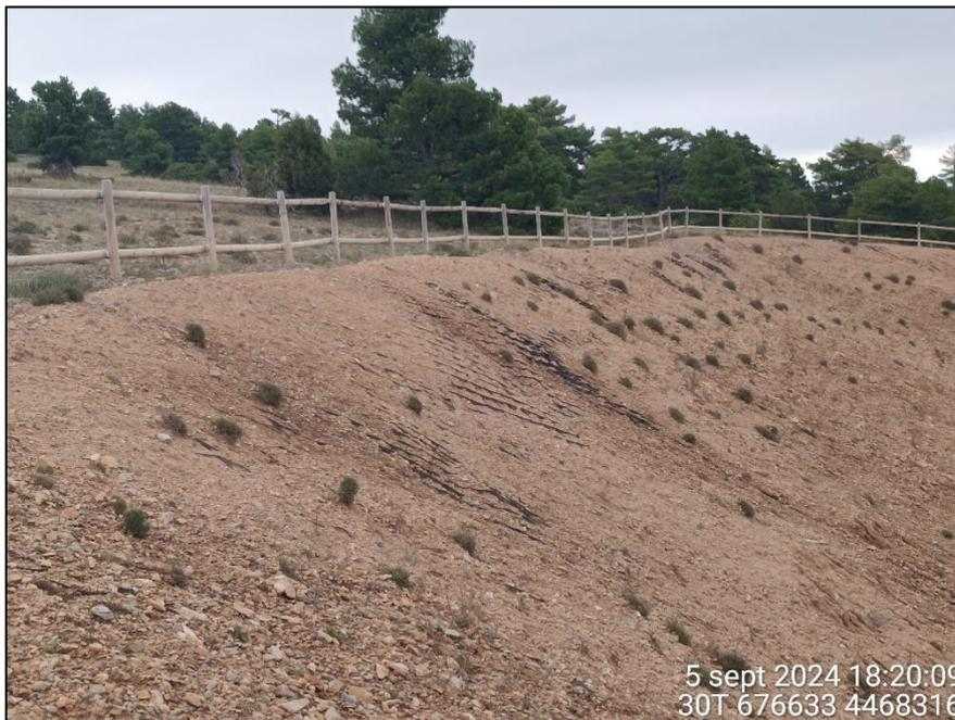
Figura 13: Geomalla textil descubierta de forma puntual en el talud del aerogenerador APE-03
