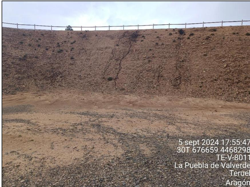
Figura 12: Pequeñas cárcavas en el talud y pequeña colada sedimentaria depositada en la plataforma del aerogenerador APE-03.
