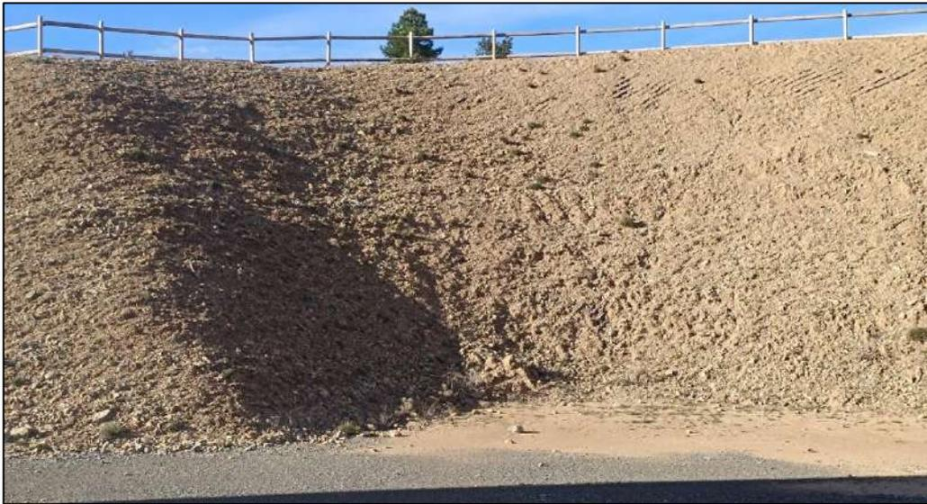
Figura 21: Estado de los taludes, con revegetación natural muy tímida y las plantas de la hidrosiembra secas.
