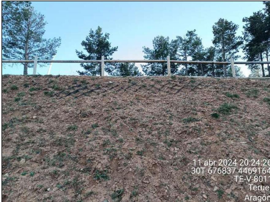
Figura 15: Geomalla textil descubierta de forma puntual en el talud del aerogenerador APE-05
