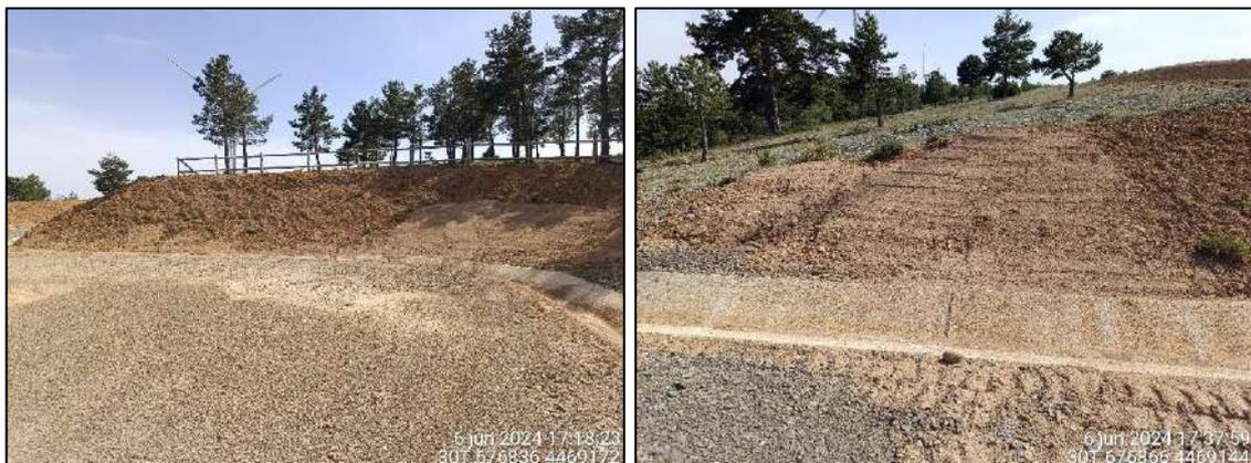
Figura 18: Tramo de talud en el aerogenerador APE-05 consolidado con los sedimentos extraídos de la cuneta.
