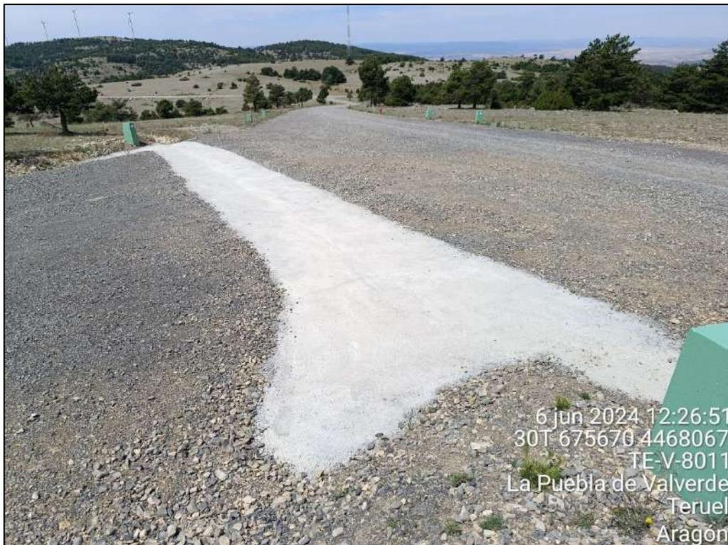
Figura 20: Trabajo de reparación en la riera formada en la entrada del vial de acceso del aerogenerador APE-01
