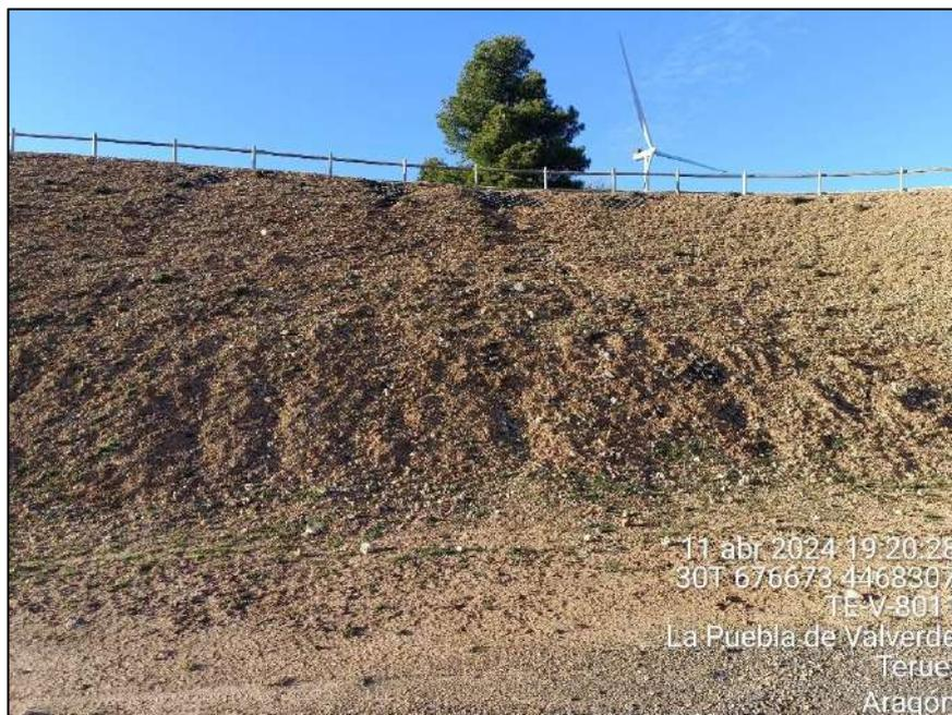
Figura 14: Pequeñas cárcavas en el talud y pequeña colada sedimentaria depositada en la plataforma del aerogenerador APE-03.
