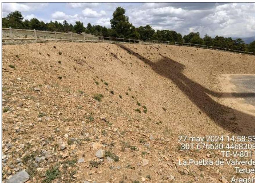
Figura 22: Tímida colonización de vegetación natural en un talud del parque eólico.
