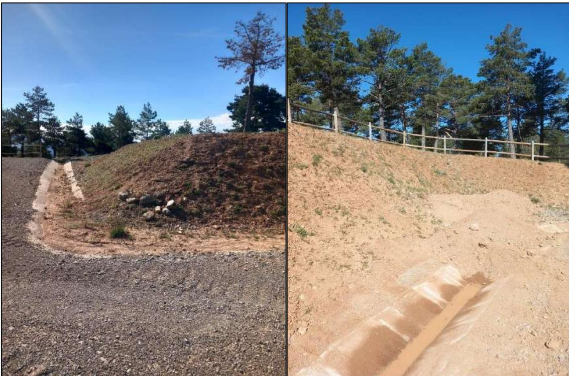
Figura 16: Trabajos de limpieza de cunetas realizados en el aerogenerador APE-05 en el Parque Eólico “Ampliación Puerto Escandón”
