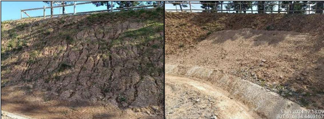
Figura 17: Tramo de talud en el aerogenerador APE-05 consolidado con los sedimentos extraídos de la cuneta antes de la limpieza (izda) y después (dcha)
