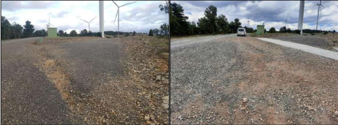
Figura 19: Riera formada en la entrada al vial de acceso al aerogenerador APE-01 en el parque eólico “Ampliación Puerto Escandón” antes de ser reparada (izda) y después (dcha)
