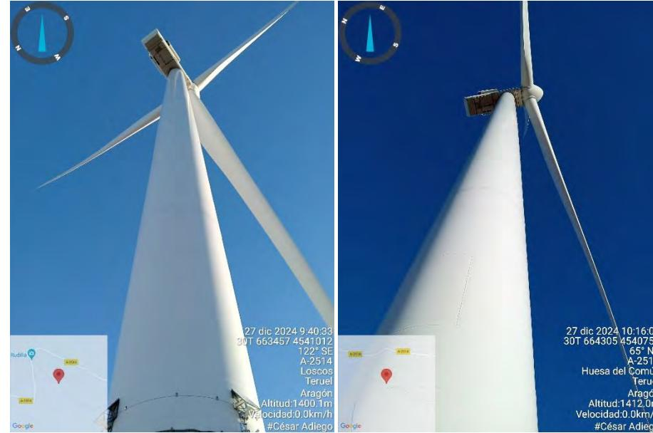
Fotografías 11 a 12: Barquillas de los aerogeneradores sin derrames
