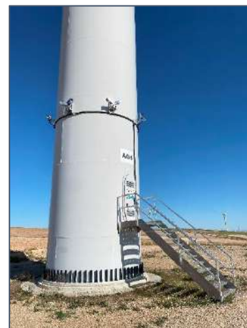
Dispositivo 3DObserver instalado en el aerogenerador A-04
