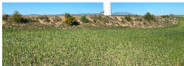
Estado general de los taludes restaurados (AG-07)
