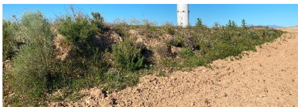
Estado general de los taludes restaurados (AG-04)
