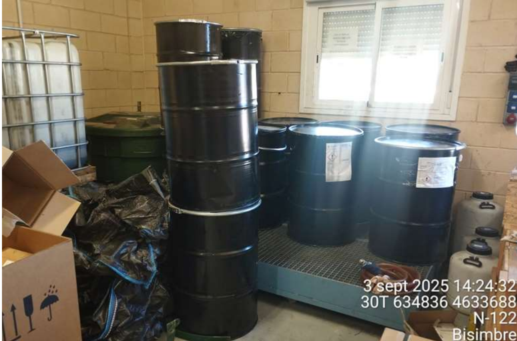
Figura 37: Interior del almacén de residuos de la SET “Valcardera”, con los recipientes de residuos peligrosos aislados de la intemperie y ubicados sobre una tarima aislante para evitar posibles filtraciones al suelo.
