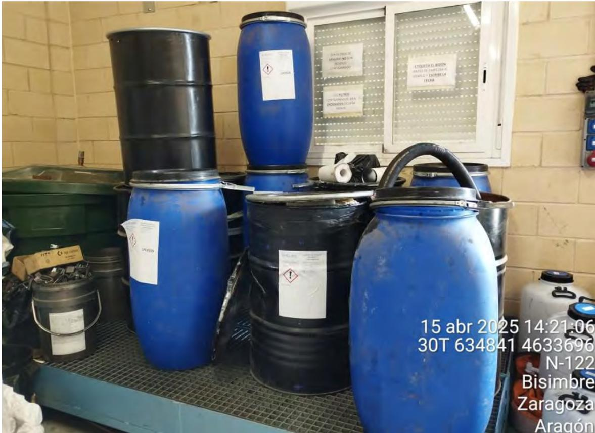
Figura 39: Interior del almacén de residuos de la SET “Valcardera”, con los diferentes residuos peligrosos aislados de la intemperie y sobre una tarima aislante para evitar posibles filtraciones al suelo.
