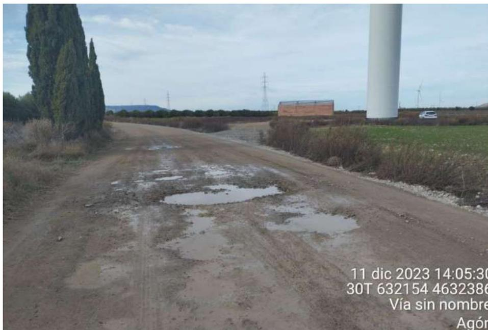
Figura 35: Vial de acceso a plataforma de AG-03. Obsérvese el tramo de vial que está deteriorado tanto por la erosión natural como por el tráfico rodado. Estas incidencias reportadas en informes anteriores se mantienen a día de hoy.
