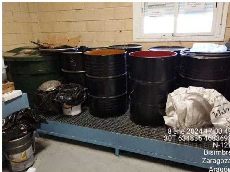
Figura 41: Interior del almacén de residuos de la SET “Valcardera”, con los diferentes residuos peligrosos aislados de la intemperie y sobre una tarima aislante para evitar posibles filtraciones al suelo.
