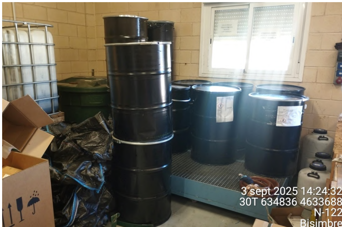
Interior del almacén de residuos de la SET “Valcardera”, con los diferentes residuos peligrosos aislados de la intemperie y sobre una tarima aislante para evitar posibles filtraciones al suelo.
