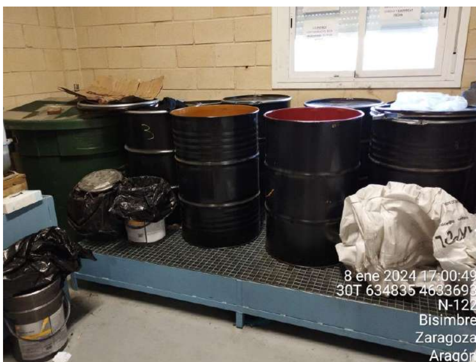
Figura 33: Interior del almacén de residuos de la SET “Valcardera”, con los diferentes residuos peligrosos aislados de la intemperie y sobre una tarima aislante para evitar posibles filtraciones al suelo.
