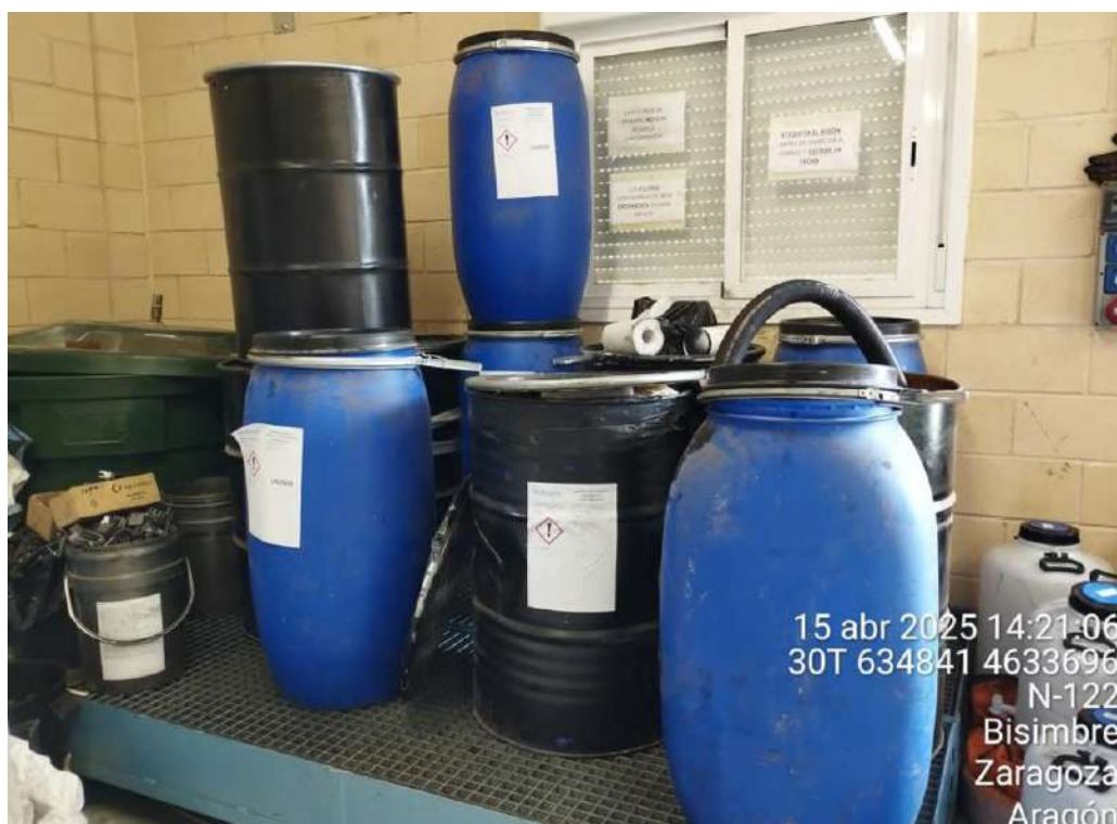
Figura 25: Interior del almacén de residuos de la SET “Valcardera”, con los diferentes residuos peligrosos aislados de la intemperie y sobre una tarima aislante para evitar posibles filtraciones al suelo.
