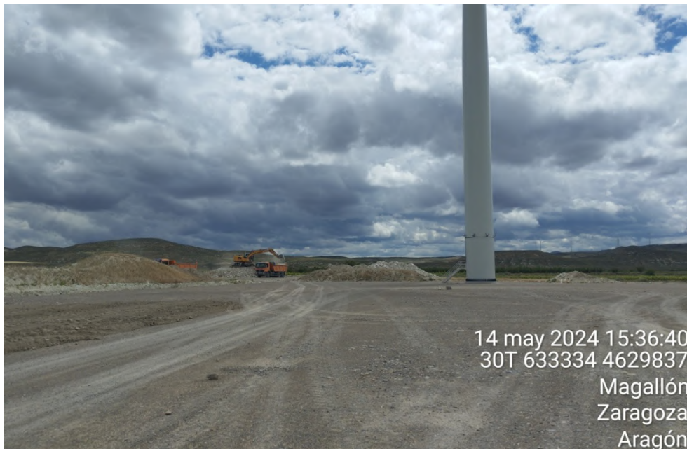
Restauración del perímetro de la plataforma de AGB-1.
