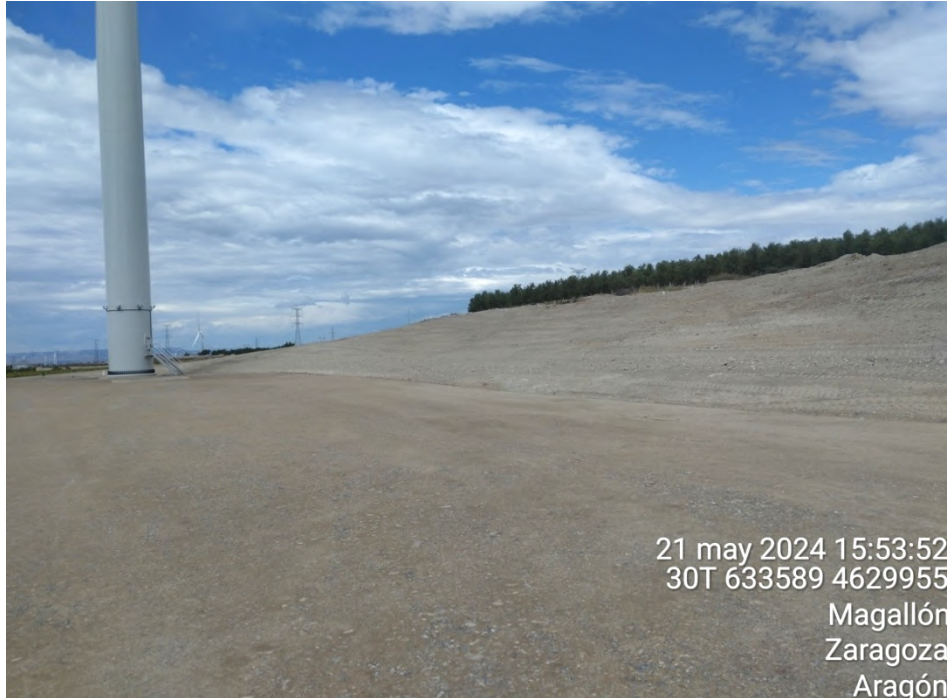
Plataforma y talud de AGB-2 finalmente restaurados el 21 de mayo de 2024.
