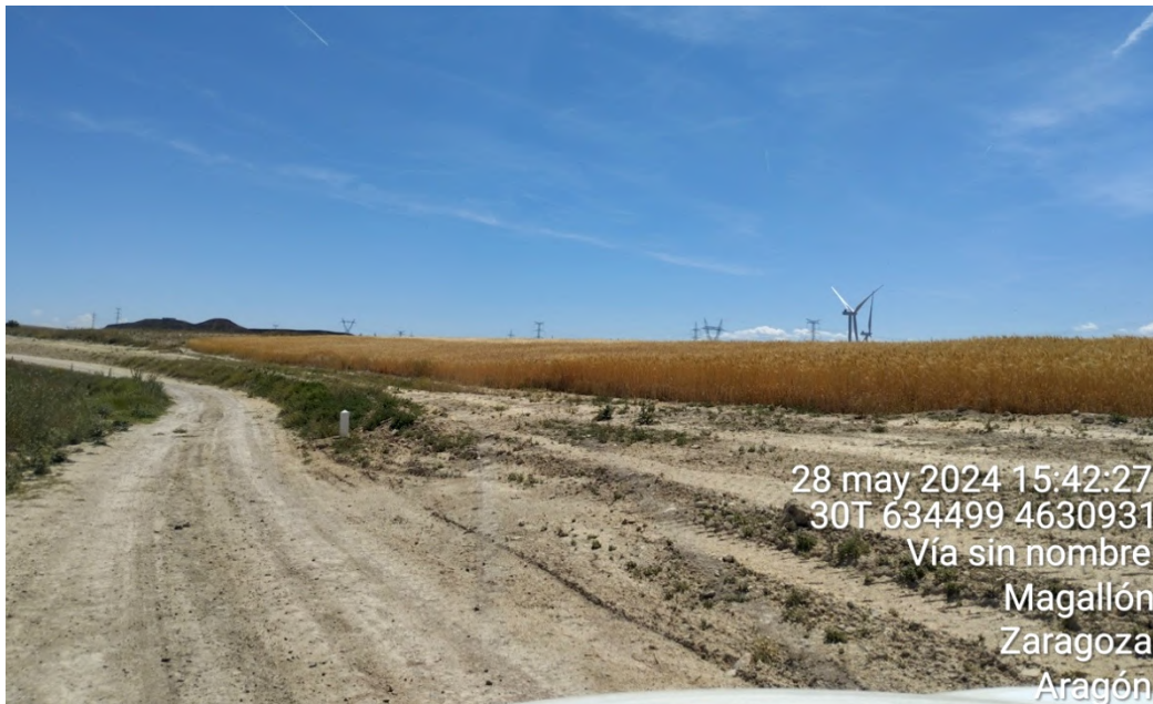
Estado del área restaurada N°1 (cable soterrado de evacuación) a finales de mayo de 2024.
