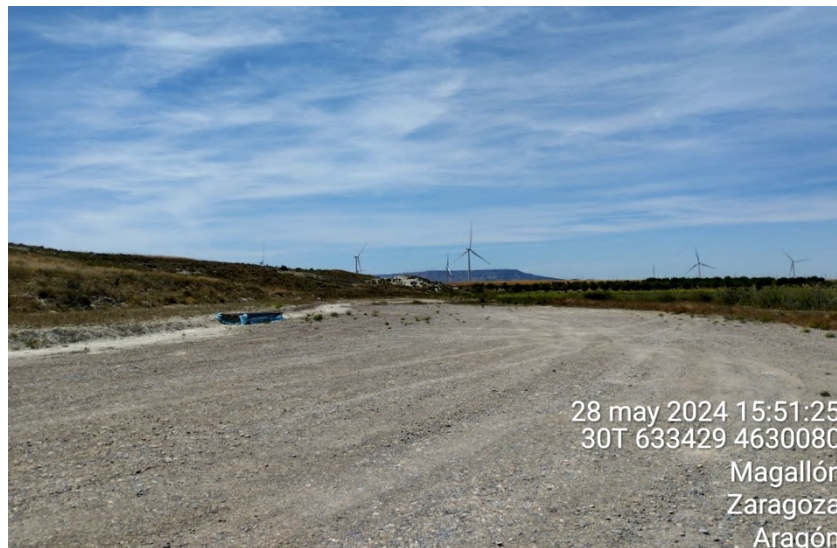
Site Camp ya desmantelado el 28 de mayo de 2024, en el que solo permanecían algunos materiales sobrantes de construcción (unas vigas de metal sobre una lona).
