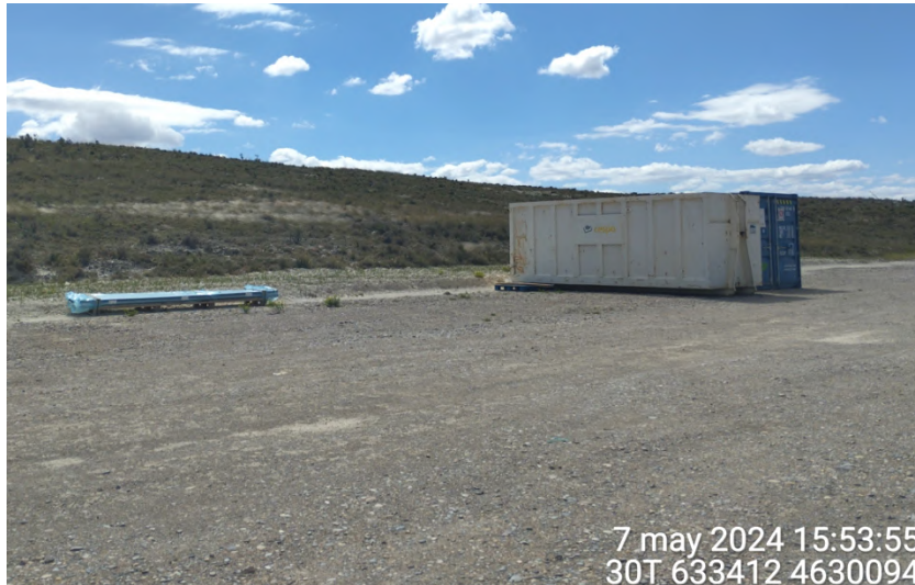
Estado del Site Camp el 7 de mayo de 2024, tras haberse retirado las casetas de obra dejando únicamente algunos materiales y los dos contenedores del punto limpio del Site Camp.
