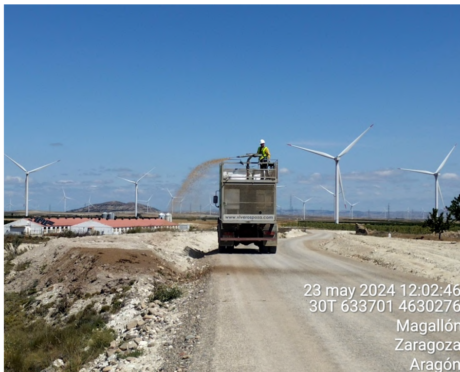
Hidrosiembra de áreas 6, 7 y 8 (perímetro del vial a la altura de granja de ganado porcino al norte del PE Agón 2).
