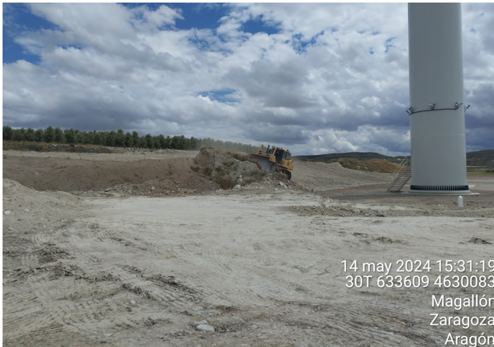
Restauración del talud de la plataforma de AGB-2.
