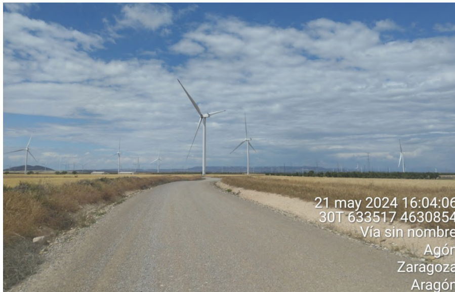
Fotografías del tramo de viales de acceso a los aerogeneradores de Agón 2 desde un PE aledaño ya construido y en explotación, ya restaurados.
