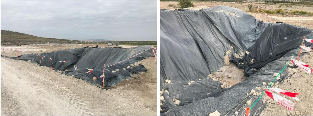
Para evitar vertidos de hormigón al traspasar el hormigón a la grúa de hormigonado, se ha colocado en el suelo un plástico que evita los vertidos sobre el suelo.
