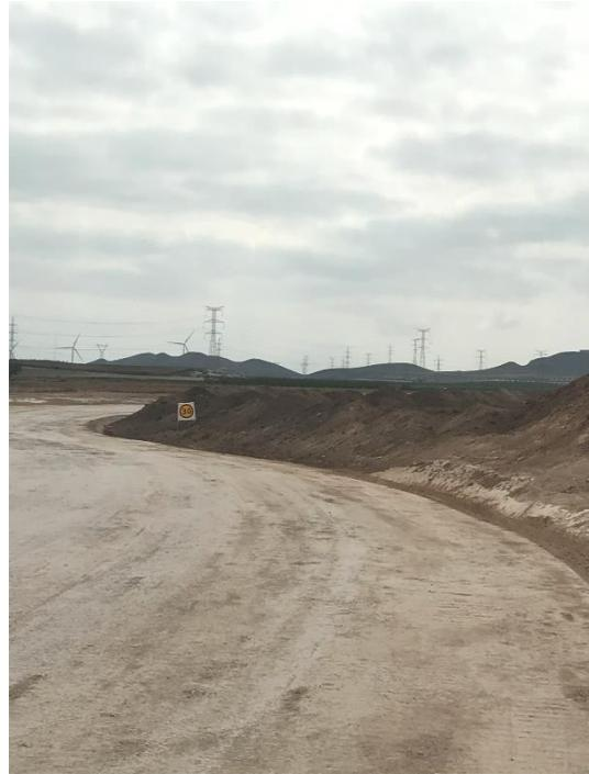
Se observa que generalmente los acopios de tierra vegetal se han almacenado separados de las tierras de excavación para evitar afecciones.
