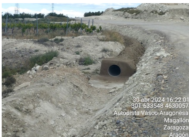
Tubos enterrados de PVC aledaños a los viales para la reconducción de algunos canales de agua preexistentes de acequias agrícolas.
