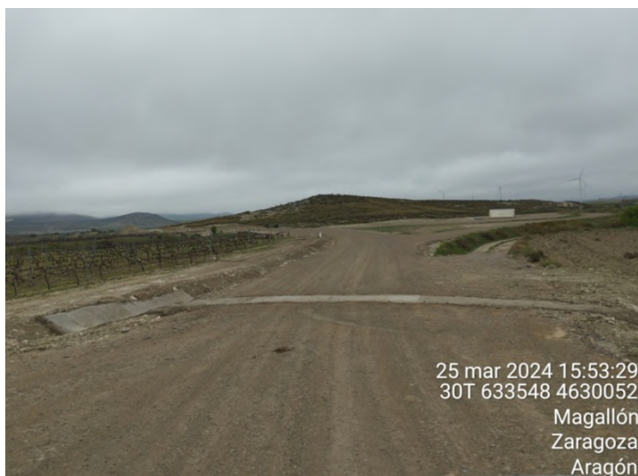
Tramos de vial en los que se han instalado canales de drenaje de agua, consistiendo en tuberías de PVC cubiertas de hormigón.
