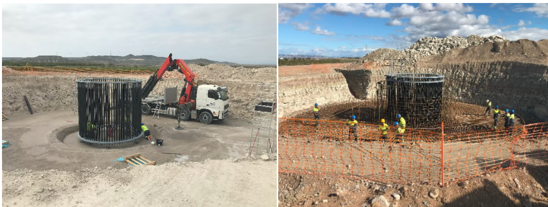
Fotografías del proceso de ferrallado durante octubre de 2023.
