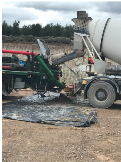
Lonas de plástico colocadas bajo la hormigonera para evitar la contaminación del suelo por derrames de hormigón, durante las operaciones de octubre de 2023.
