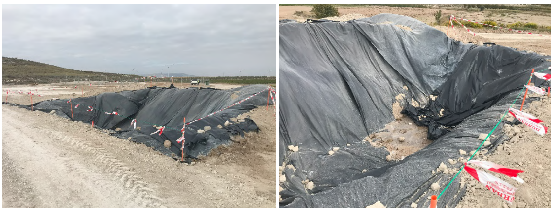
Piscinas de lavado de hormigón preparadas en los viales de acceso a la obra, a octubre de 2023.
