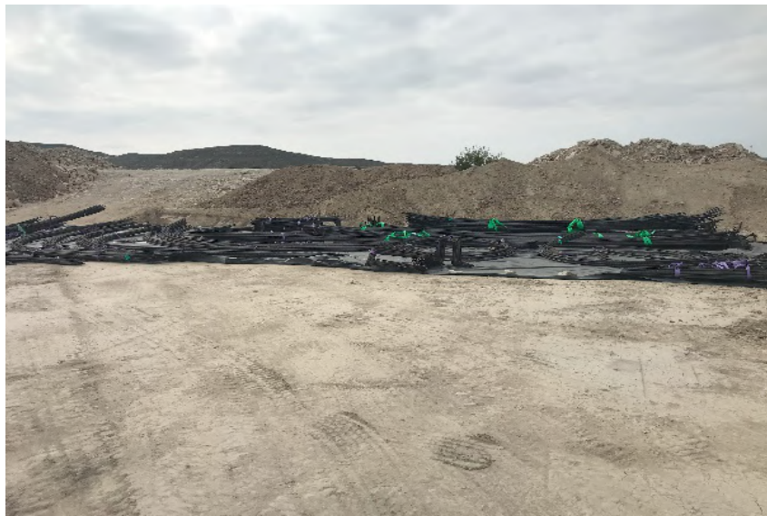
Vigas de metal de la fase de ferrallado apoyadas sobre lonas de plástico para evitar contaminación del suelo por aceites lubricantes y otras sustancias.
