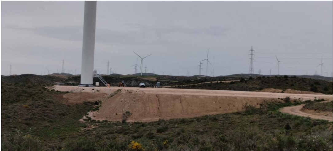
Estado de la plataforma del aerogenerador ACS 01, tras su completo izado y la retirada de la grúa y elementos auxiliares
