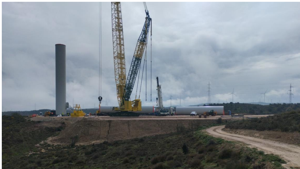
Plataforma del AC 01 vista desde el oeste. Destaca el T1, ya izado (11-03-25)
