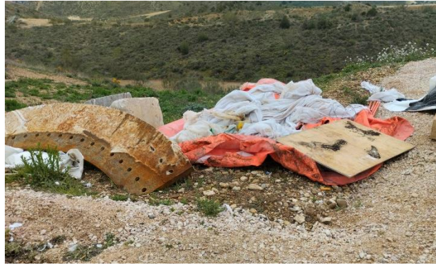
Pequeño acopio de RNP de la fase anterior de obras, pendiente de retirada (17-03-25)
