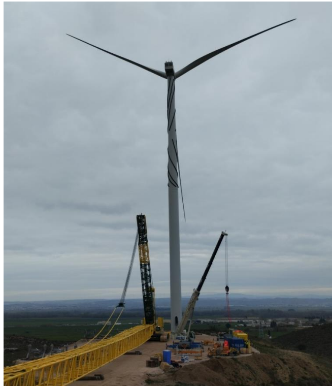
Plataforma del AC 01 desde el sur (17-03-25)
