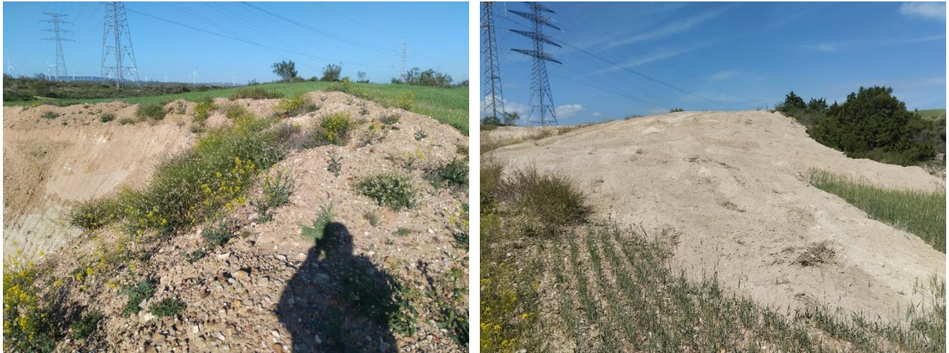
Izda., acopio de tierra vegetal ubicado en la cabecera del talud de la zona de giro, reservado para la restauración. Dcha., estado de ese mismo entorno, tras la retirada y reextendido de la tierra vegetal
