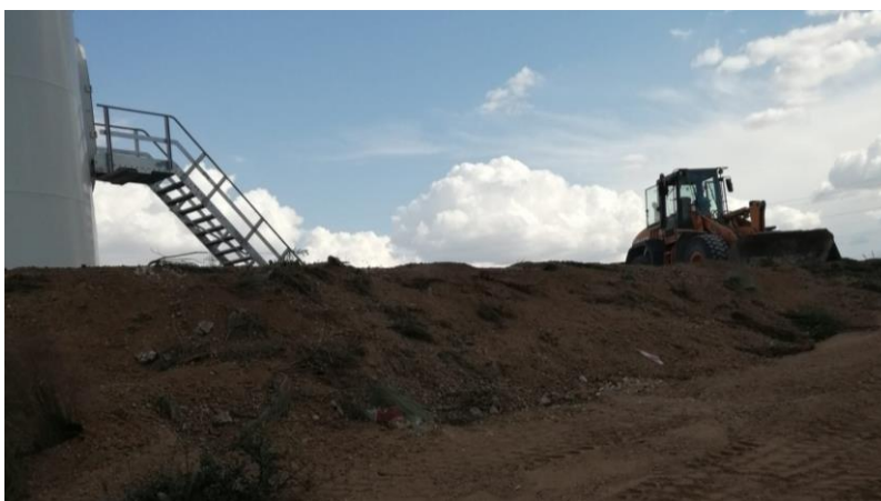
Extendiendo tierra vegetal en la plataforma auxiliar del aerogenerador ACS 01 (13-05-25)
