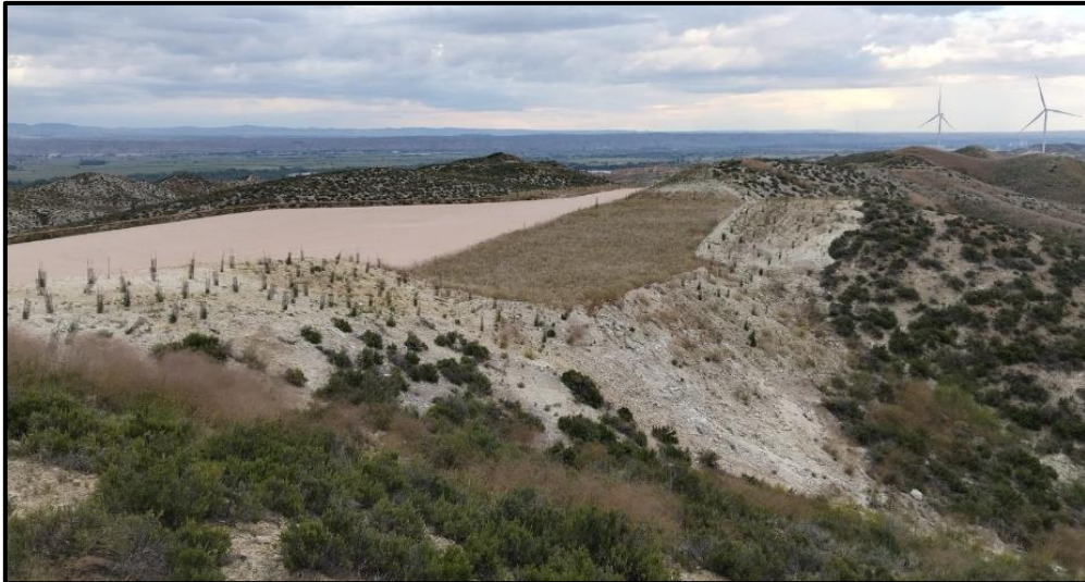
Fotografía 1. Vista general de la plataforma de la turbina ACS05
