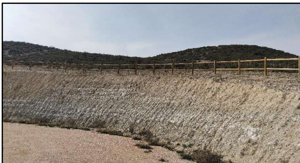
Fotografía 2. Ejemplo de ausencia de erosión en desmontes y taludes (turbina ACS05)
