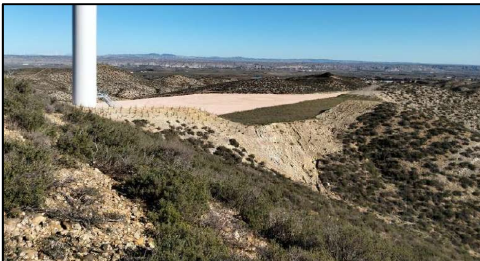
Fotografía 10. Vista general de posición de la turbina ACS05
