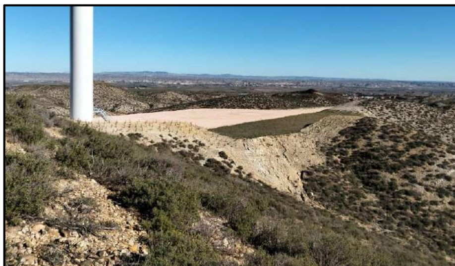
Fotografía 12. Vista general de la turbina ACS05
