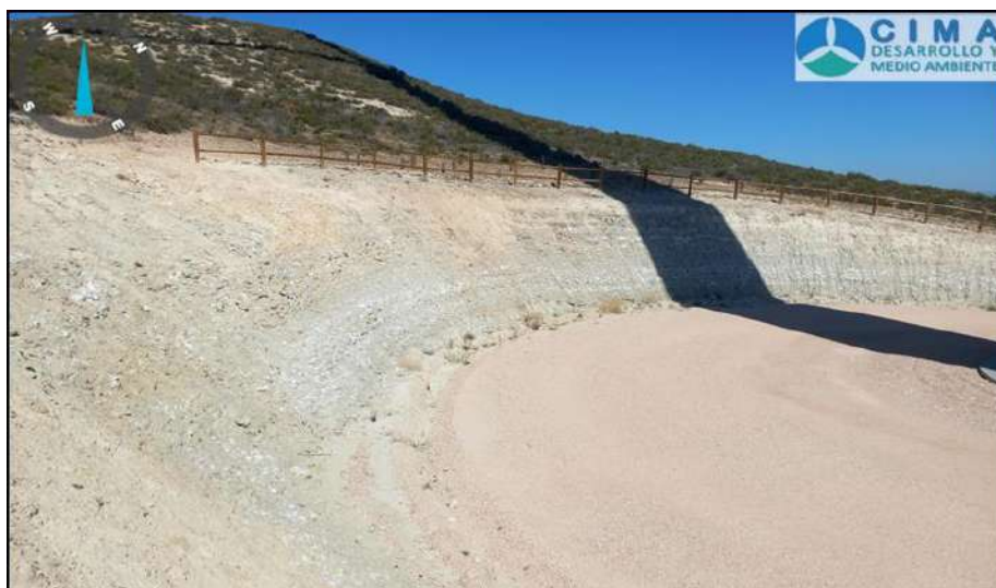
Fotografía 1. Ejemplo del estado de los desmontes y taludes sin signos de erosión (cárcavas o desprendimientos)
