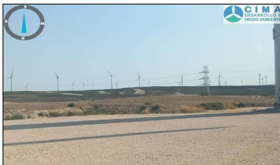
Fotografía 3. Vista general en la turbina ACS02.
