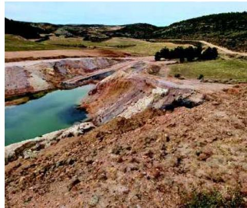
**Figura 6.** Fotografías 1 a 4. Arriba, vista general de la zona rehabilitada enlazando con los campos de cultivo existentes. Abajo, hueco final usado como balsa para agua.
