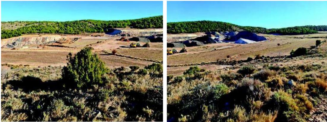
**Figura 4.** Zona rehabilitada: en primer término la destinada actualmente como zona de acopios; en sobre cota con esta, zona rehabilitada con extensión de tierra vegetal, enlazando con el terreno natural
