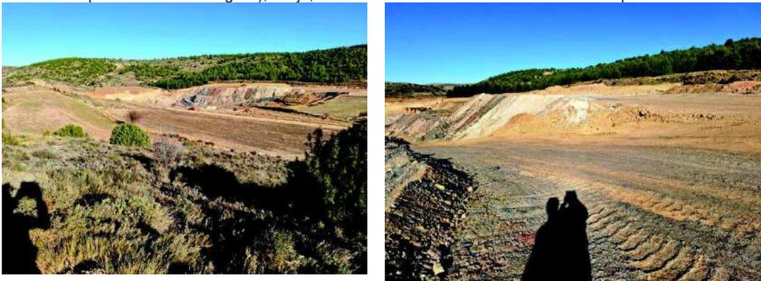
**Figura 3.** Detalle del avance del relleno del hueco final realizado por transferencia y la parte ya finalizada con reposición de tierra vegetal enlazando con el terreno natural
