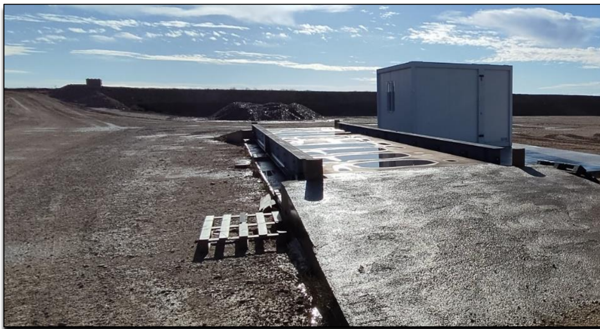
Figura nº 29. Zona de recepción y control de acceso con báscula y caseta.
