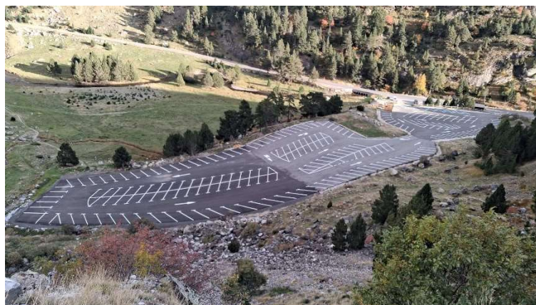
Imagen asfaltado nuevo (izquierda de la imagen).
