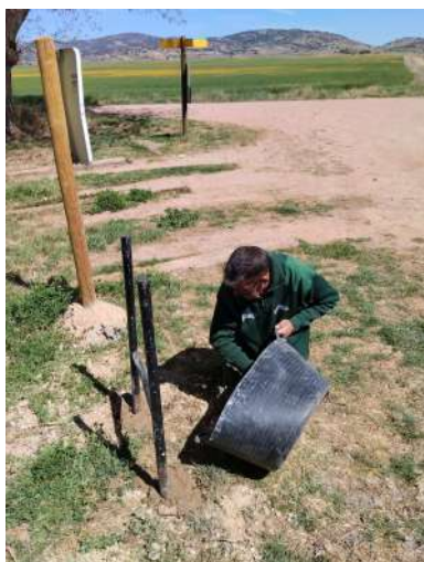
Peón colocando papeleras con hormigón.
