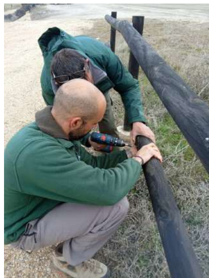
Mantenimiento del vallado del parking del C.I.
