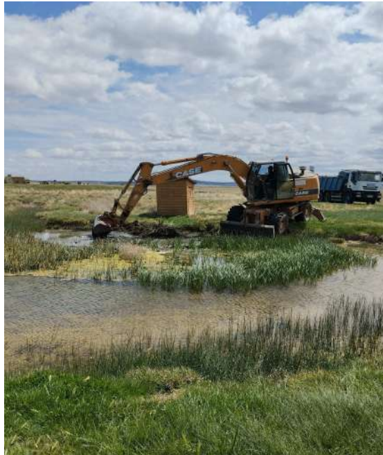
Retroexcavadora limpiando en las Fuentecillas.
