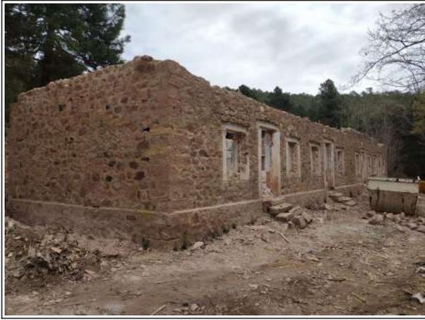
Demolición del tejado y de las paredes interiores. Abril 2024.
