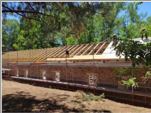
Colocando la cubierta de madera sobre la que irá la teja. Julio 2024.
