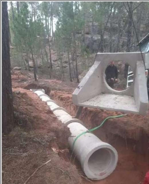
Colocando tubo de hormigón con arqueta con arqueta y embocadura.
