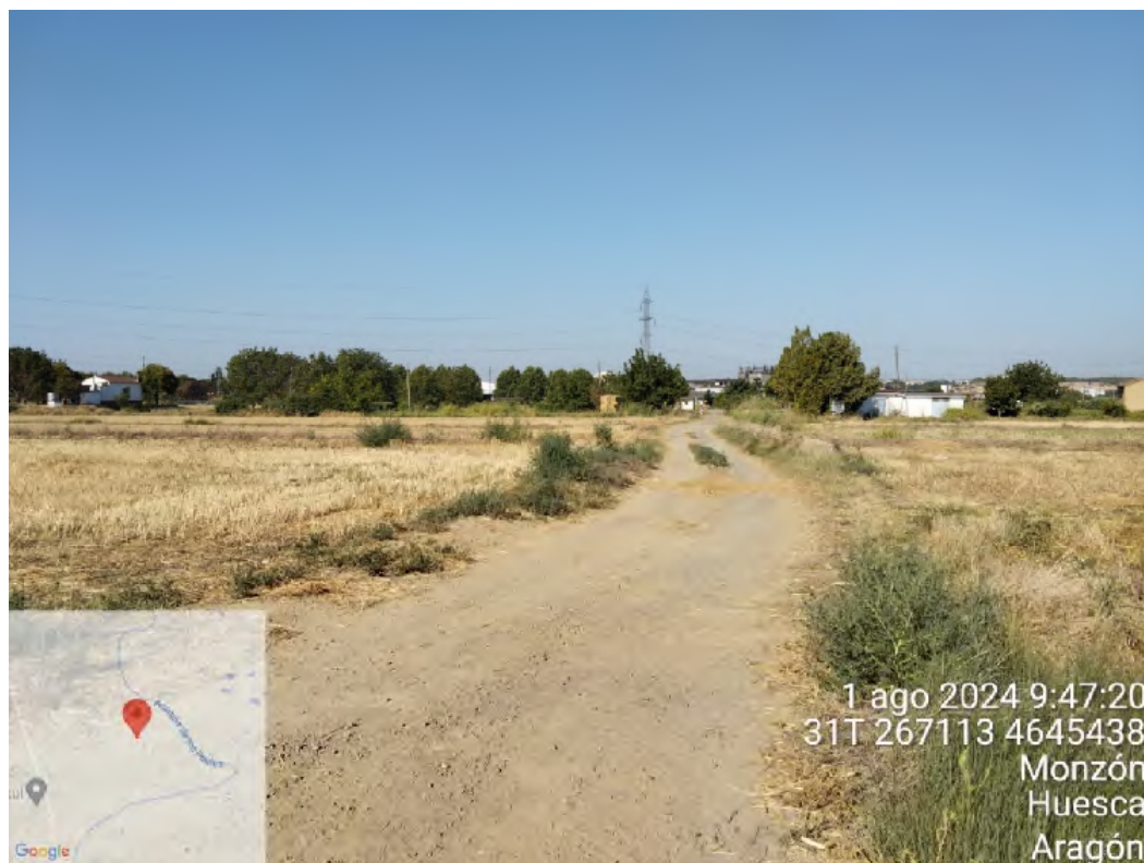
Camino agrícola por el que discurrirá la conducción a unos 390 m al Este del polígono industrial en Monzón
