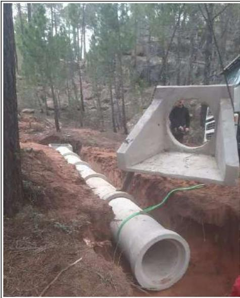
Colocando tubo de hormigón con arqueta y embocadura.
