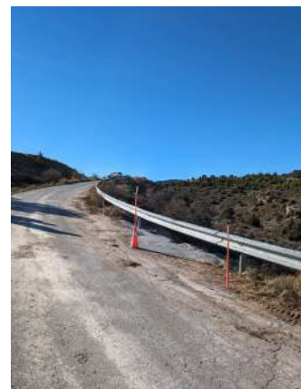
Pista asfaltada después de la actuación.
