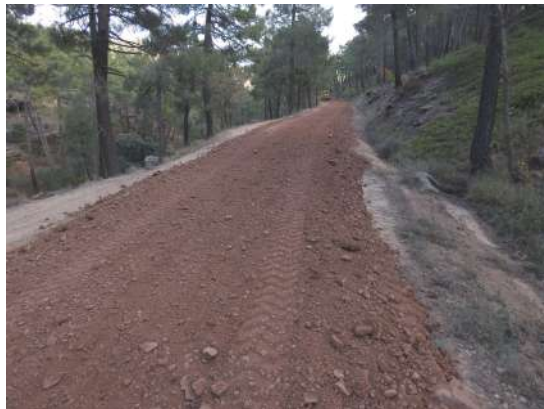
Motoniveladora al fondo trabajando en la pista Laguna de Bezas.
