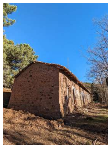
Sin vegetación alrededor del edificio.
