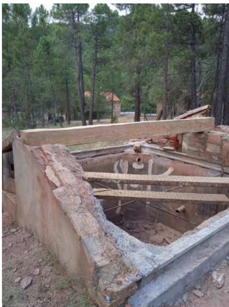
Obras en el caseto que protege un aljibe de agua.
