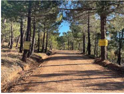
Pista refinada y limpiada las cunetas con motoniveladora.
