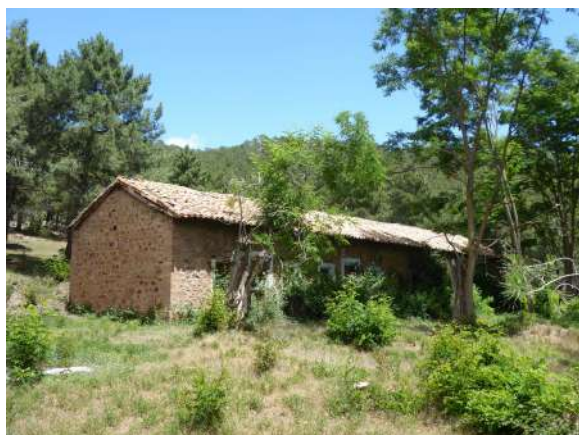
Vegetación alrededor del edificio.
