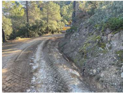
Retroexcavadora al fondo limpiando las cunetas.
