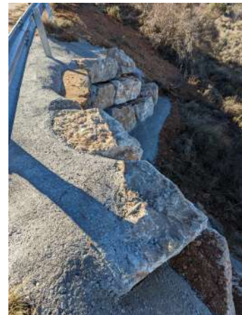
Salida de agua después de la actuación.
