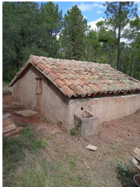
Estado final del caseto.
