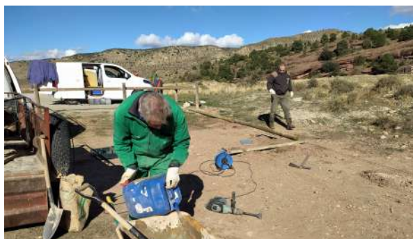
Delimitar plazas de aparcamiento en la Escombrera.
