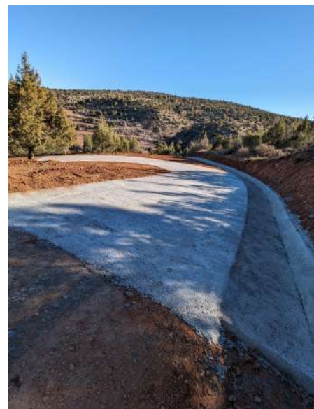
Badén de hormigón en la pista Laguna de Bezas.
