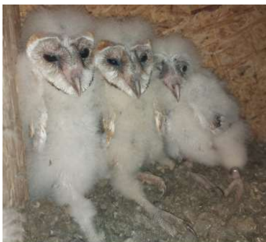
Crias del transformador Mejana del Burgo
