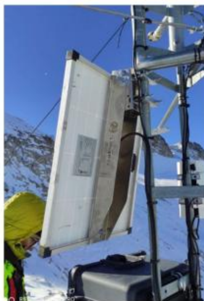
Panel solar de reposición instalado.
