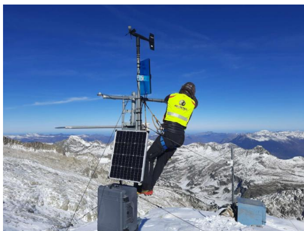
Trabajos en el sensor de espesor de nieve e instalación de antena de alta ganancia, 2022
