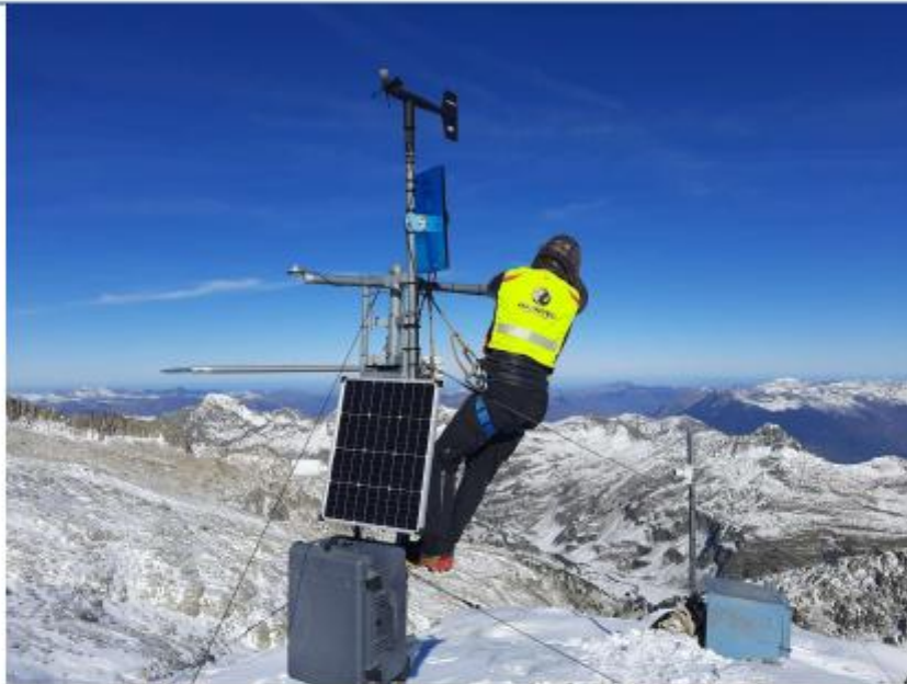
Trabajos en el sensor de espesor de nieve e instalación de antena de alta ganancia
