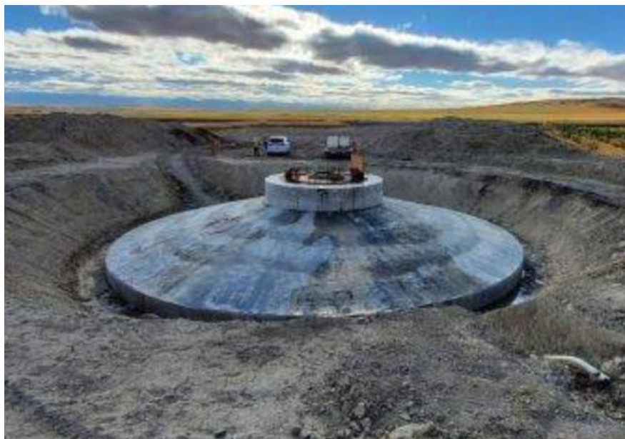
Imagen de cimentación tipo de Aerogenerador
