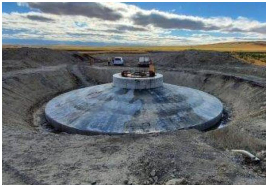
*Imagen de cimentación tipo de Aerogenerador*
