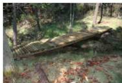
Pasarela en Barranco el Regajo
