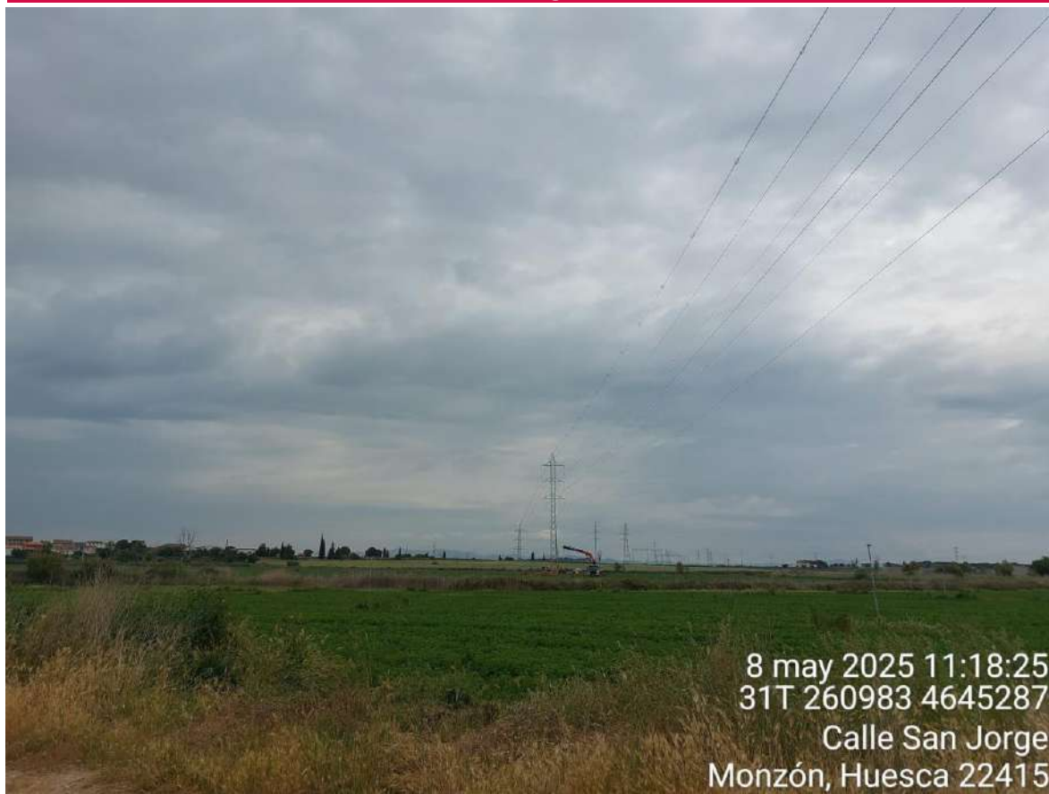
Imagen 1. Trabajos de encepado en el apoyo 53.
