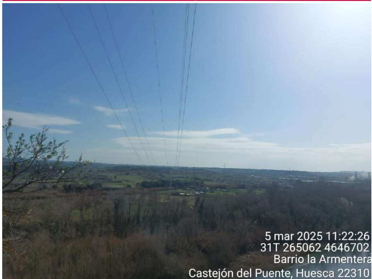
Imagen 1. Tendido de cable entre los apoyos 71 y 72 realizados cumpliendo la DIA.
