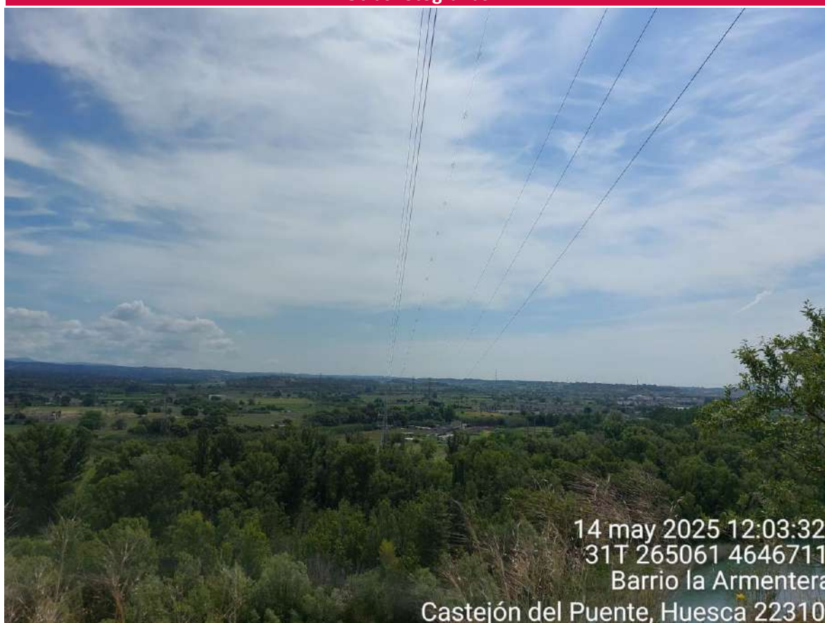
Imagen 1. Panorámica desde el apoyo 71 con los salvapájaros instalados.
