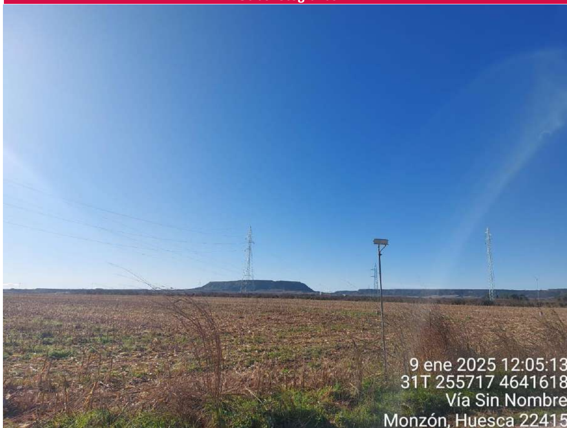
Imagen 1. Tendido de cable entre apoyos de LAT SC-Monzón.
