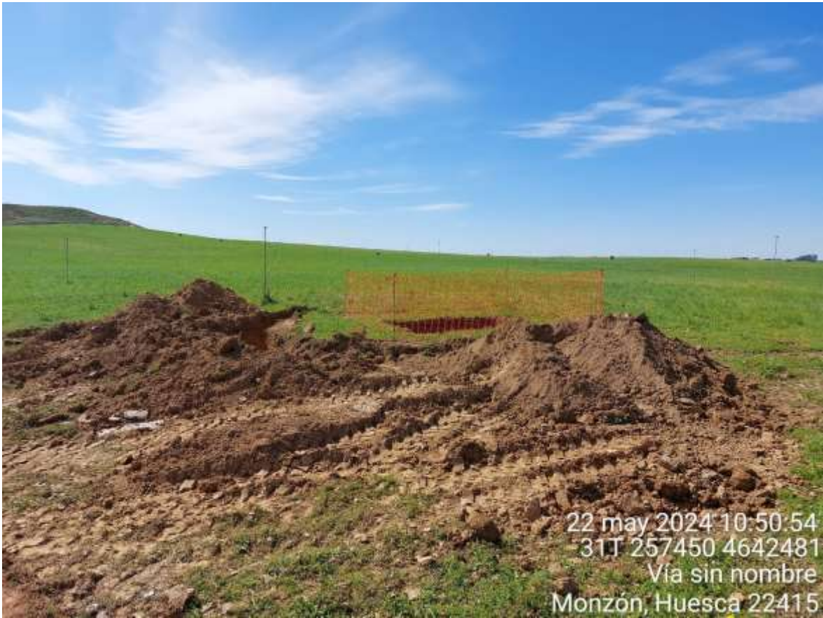
Imagen 1. Trabajos de excavación en el apoyo 37.
