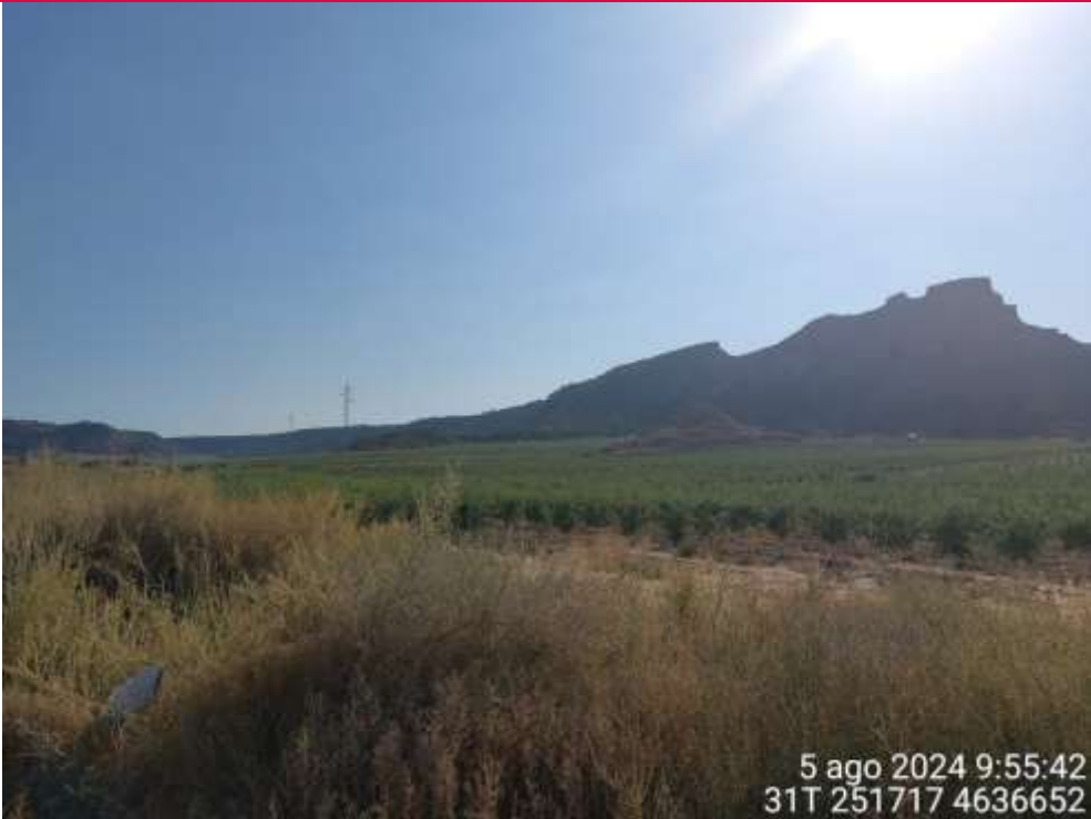
Imagen 1. Vista de los primeros apoyos de la LAT SC1 izados.
