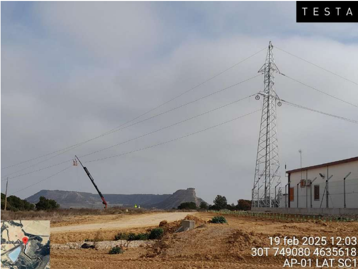
Imagen 1. Apoyo 01 de la LAT SC1
