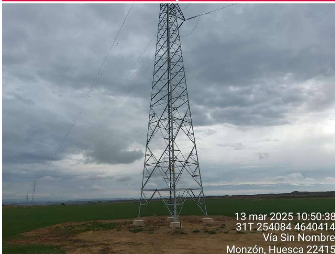
Imagen 1. Tendido de cable con salvapájaros en tramo de LAT SC-Monzón.
