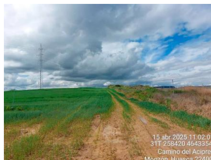
Acceso y vista del apoyo 41
