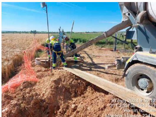
Hormigonado apoyo 31
