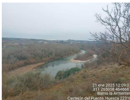
Comprobación apoyos 71-72 y la no afección de los chopos del río Cinca.
