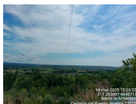
Vista desde apoyo 71 salvapájaros instalados.
