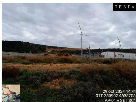
LAT, apoyo1, SET SC1 y aerogeneradores SC1-01 y SC1-02
