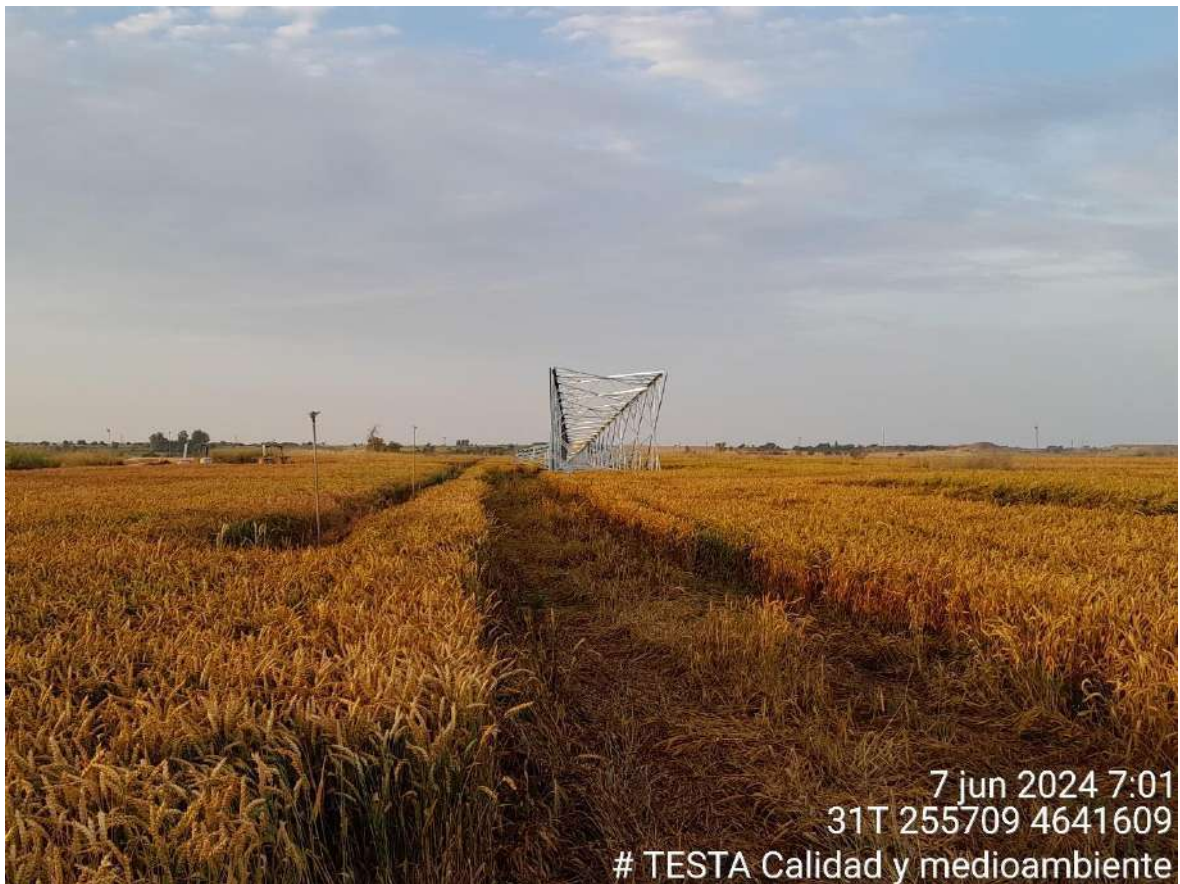
Imagen 1. Apoyo de la LAT SC1
