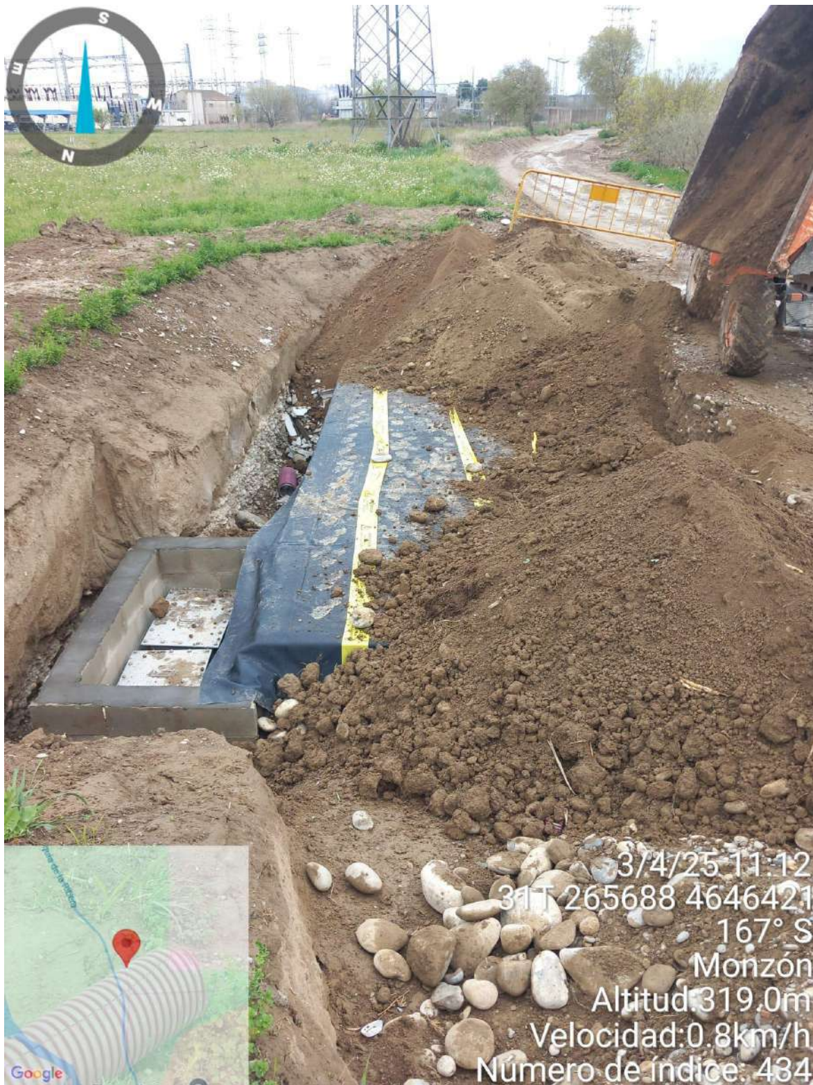
Imagen 1. LAT SC1. CE3. Tapado de cámara de empalme.
