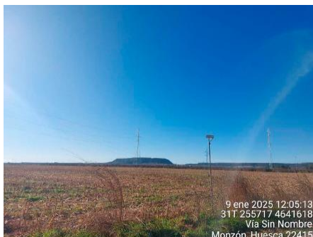
Tendido cables entre apoyos
