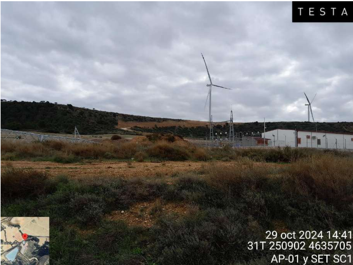
Imagen 1. Imagen panorámica del Apoyo 1 de la LAT SC1, la SET SC1 y los aerogeneradores SC1-01 y SC1-02
