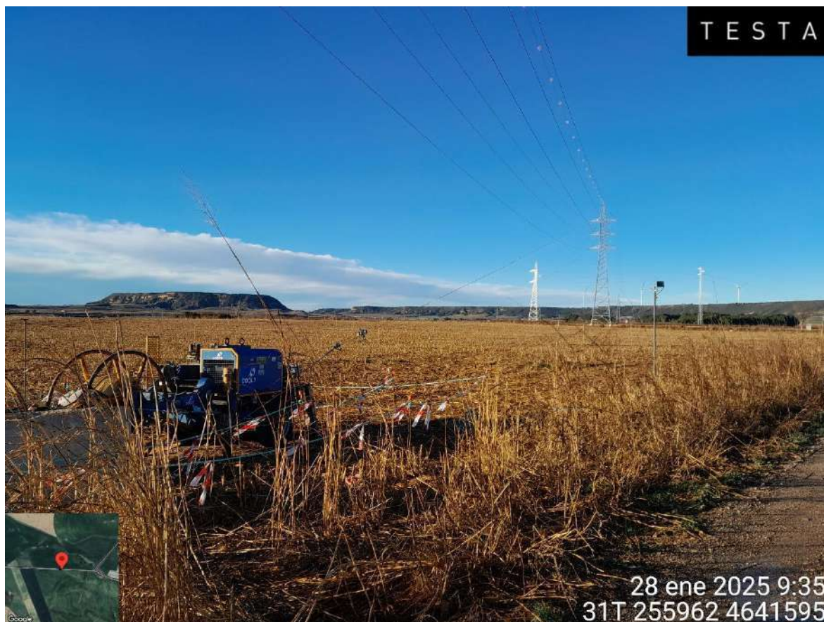
Imagen 1. Tirada de cable, en los apoyos de la LAT SC1
