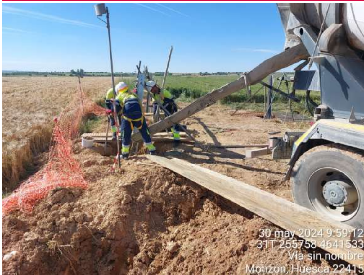
Imagen 1. Hormigonando el apoyo 31.
