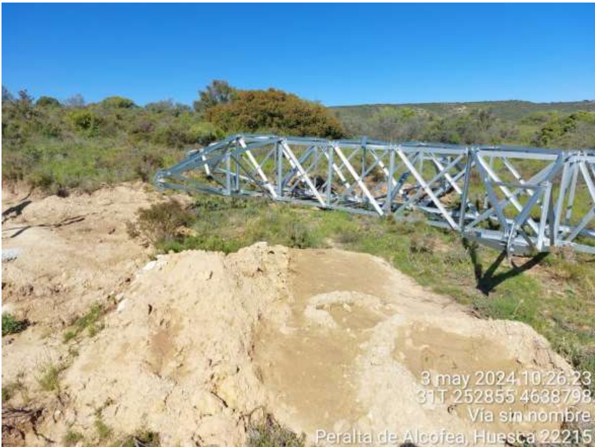
Imagen 1. Apoyo de LAT SC1 pendiente de izado.
