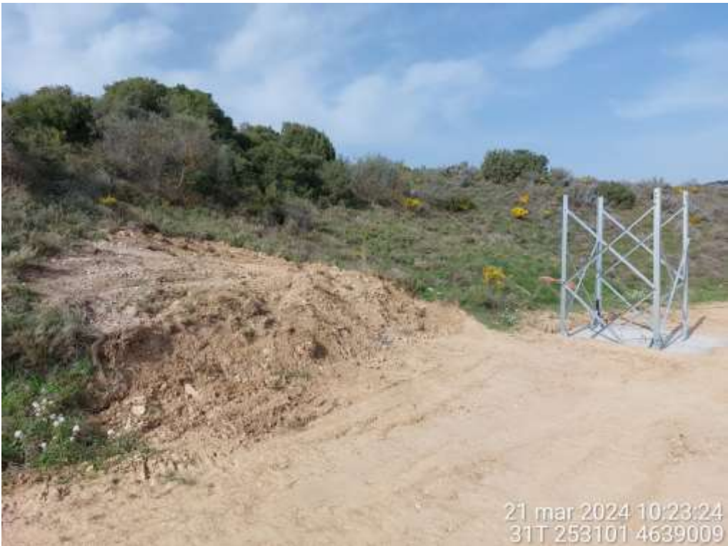
Imagen 2. Apoyo 17 tras hormigonado.
