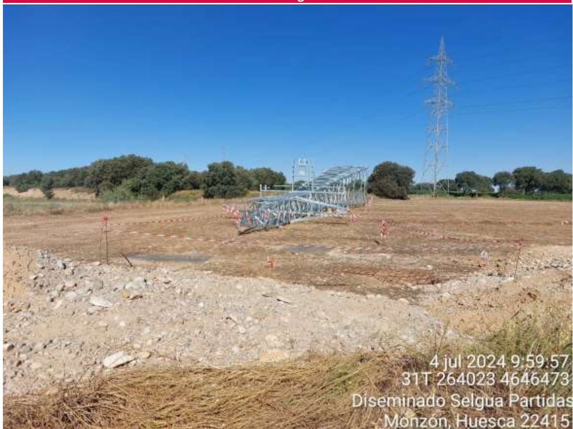
Imagen 1. Apoyo 67 montado en el suelo sin izar.
