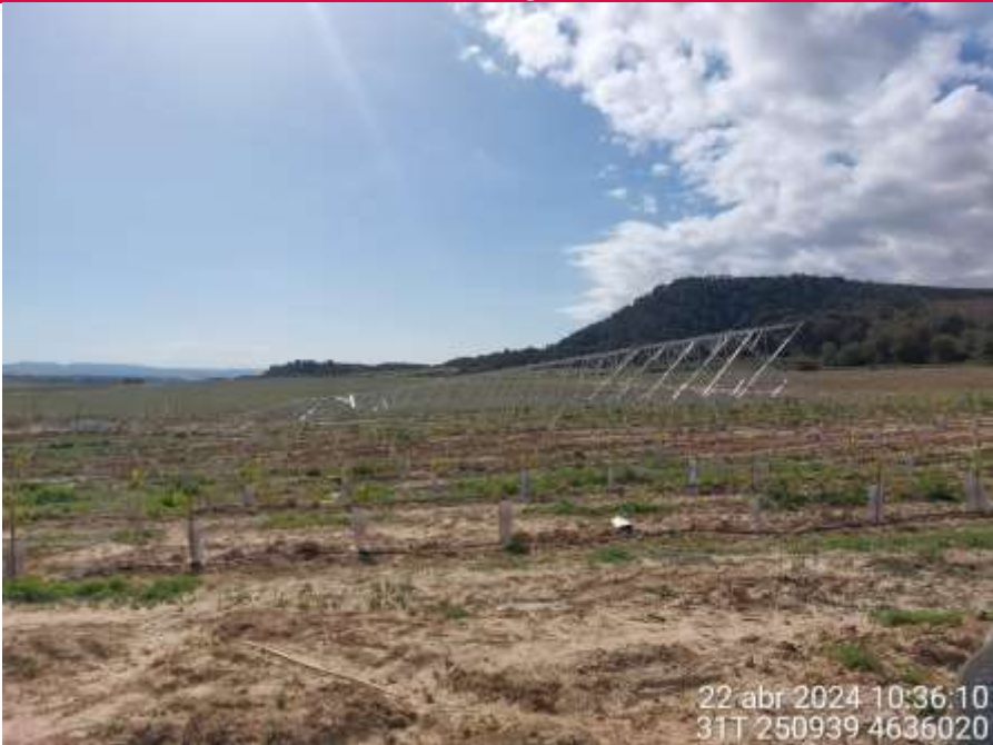
Imagen 1. Apoyo de LAT SC1 sin montar.
