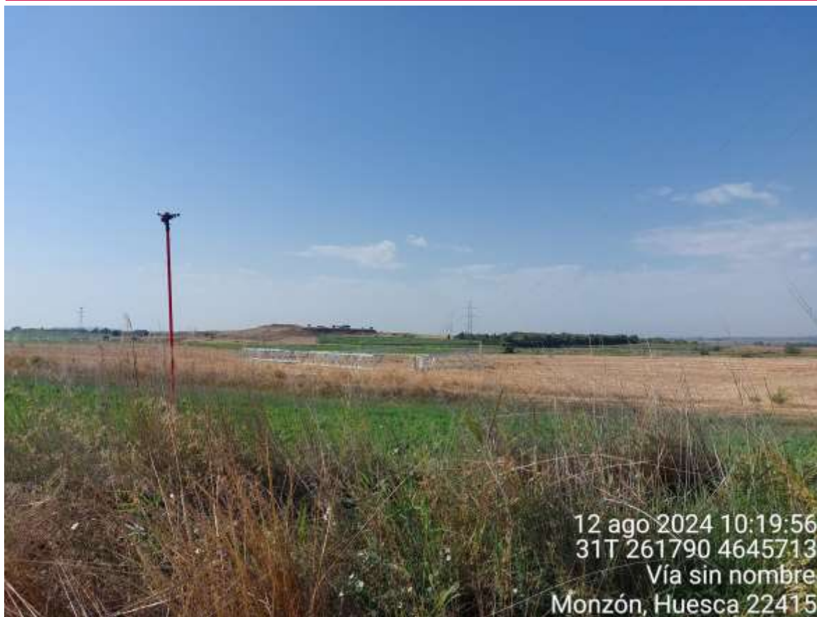
Imagen 1. Apoyo 57 montado a la espera de ser izado.
