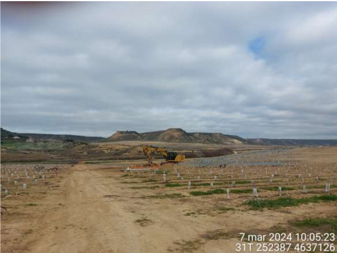
Imagen 1. Maquinaria trabajando en apoyo 10.
