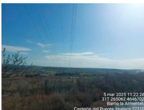
Tendido de cable entre los apoyos 71 y 72 realizados cumpliendo la DIA.
