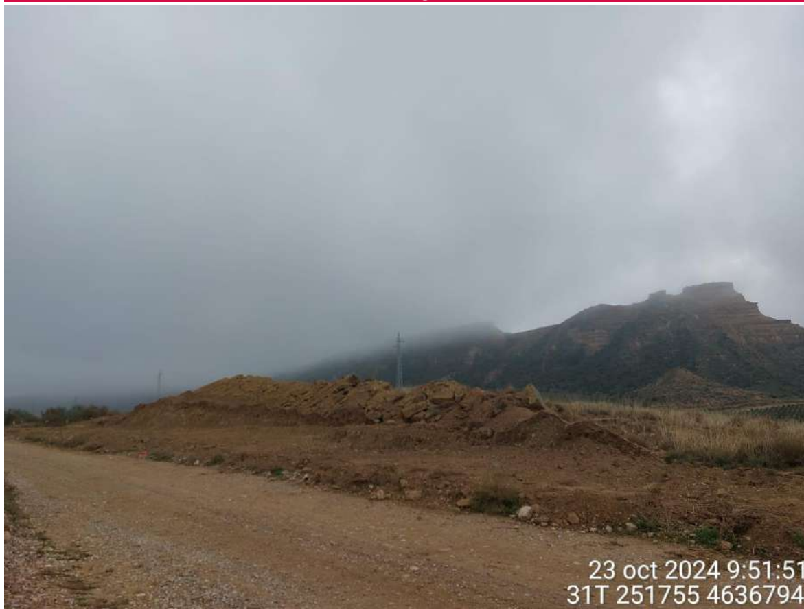
Imagen 1. HINCA en la zona de ADIF.
