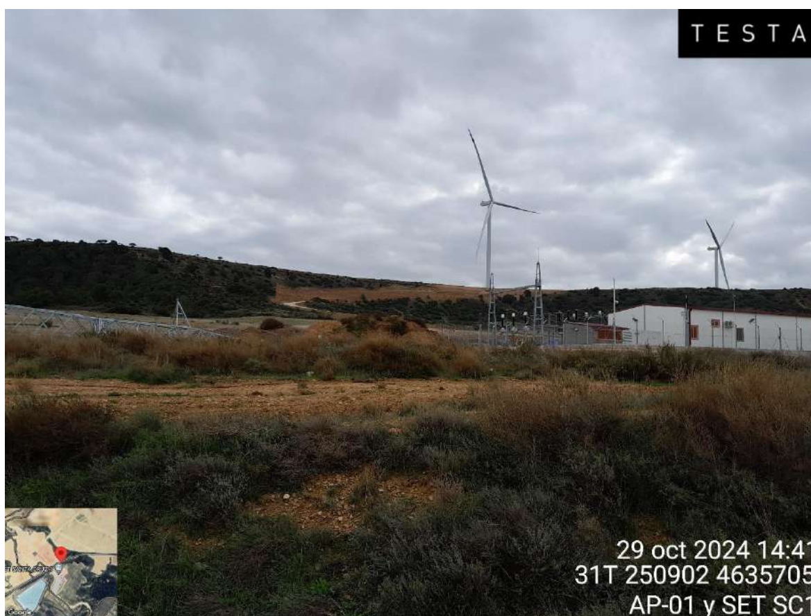
Imagen 1. Imagen panorámica del Apoyo 1 de la LAT SC1, la SET SC1 y los aerogeneradores SC1-01 y SC1-02
