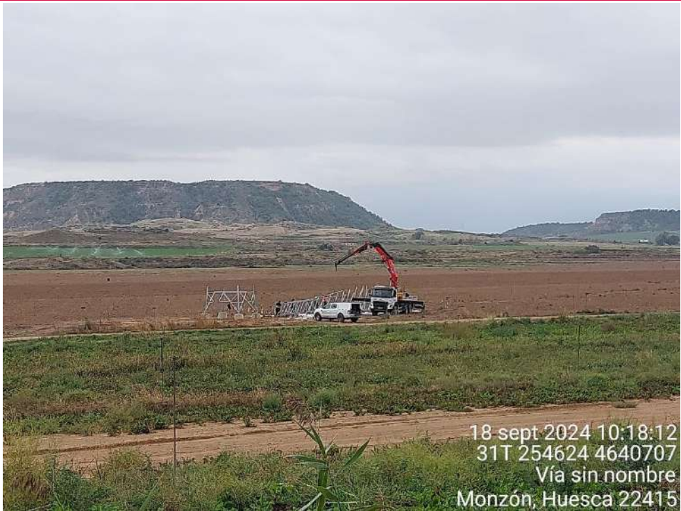
Imagen 1. Apoyo 25 con trabajos de montaje en el suelo.
