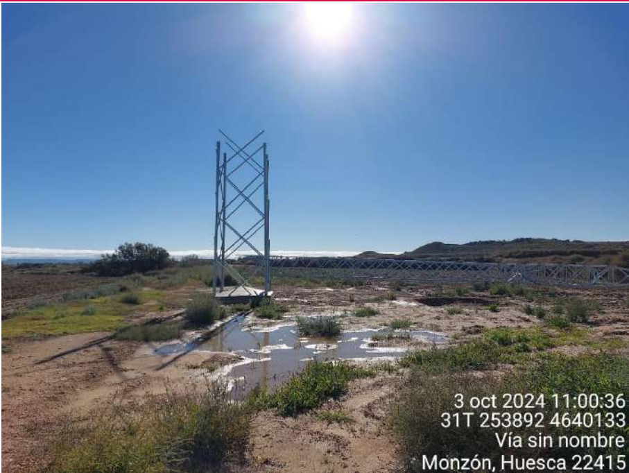
Imagen 1. Apoyo 21 de LAT SC-Monzón armado a la espera de ser izado.
