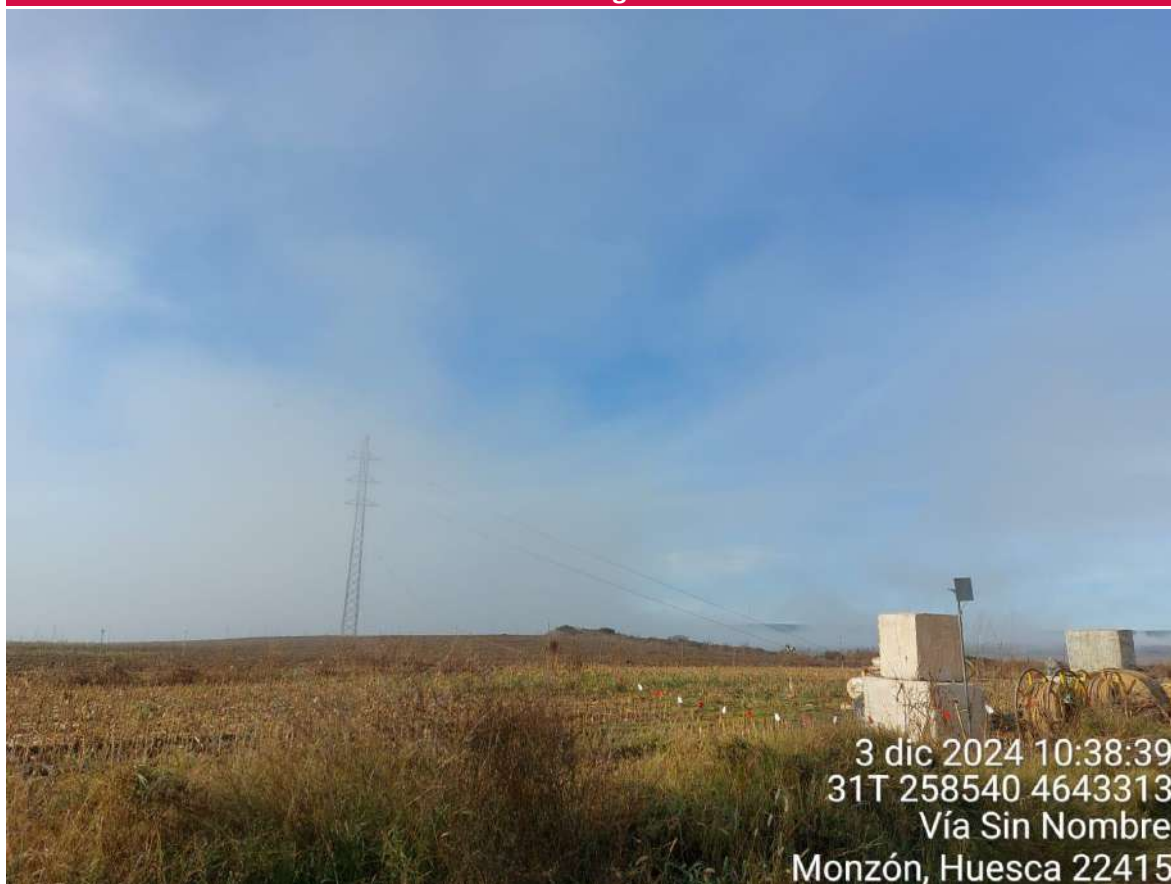
Imagen 1. Primeras fases de tendido de cable en SC1.
