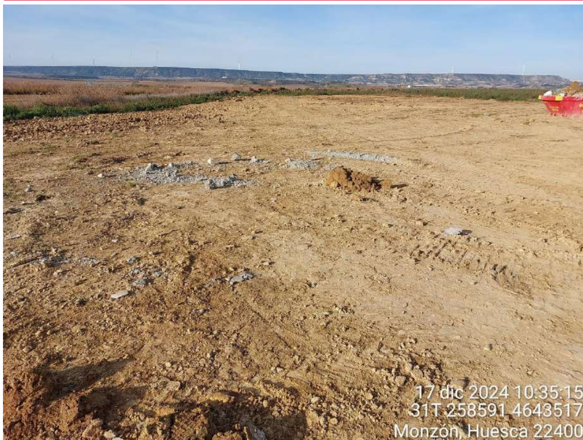
Imagen 1. Restos de hormigón a retirar durante la semana.
