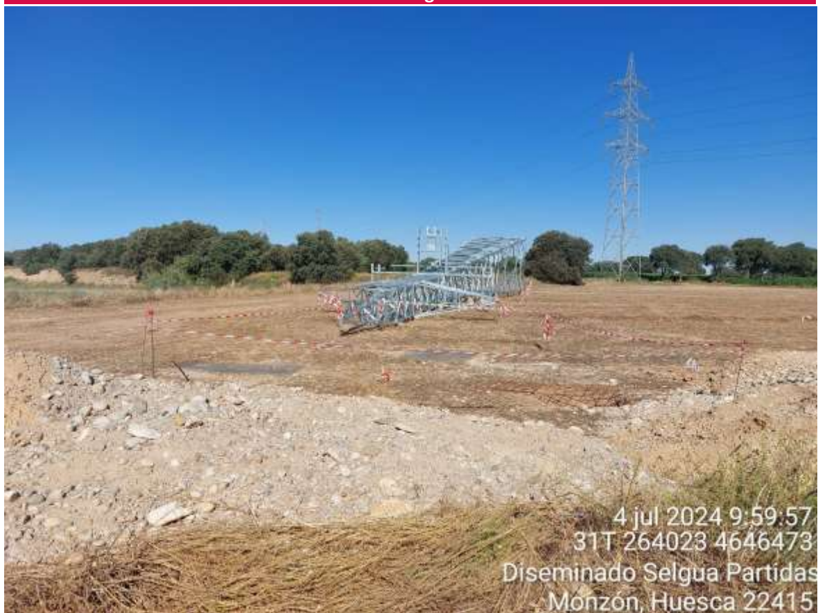
Imagen 1. Apoyo 67 montado en el suelo sin izar.
