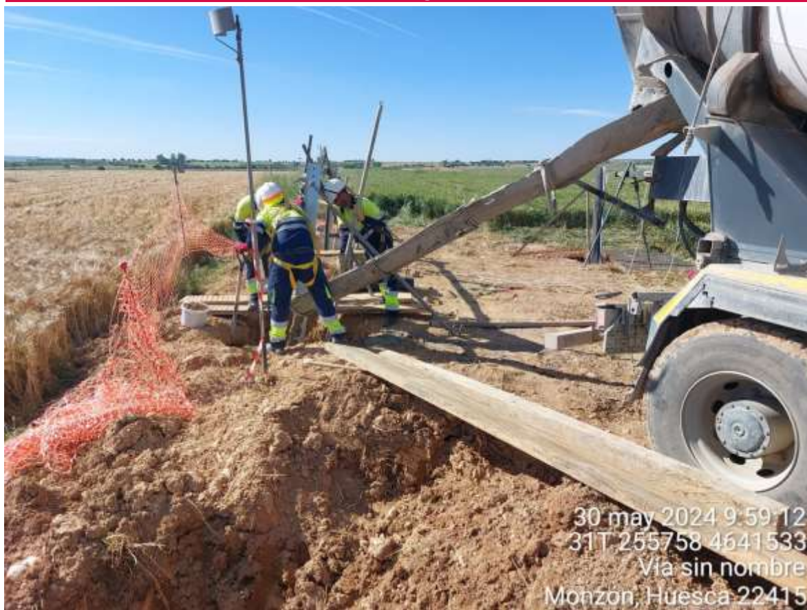
Imagen 1. Hormigonando el apoyo 31.
