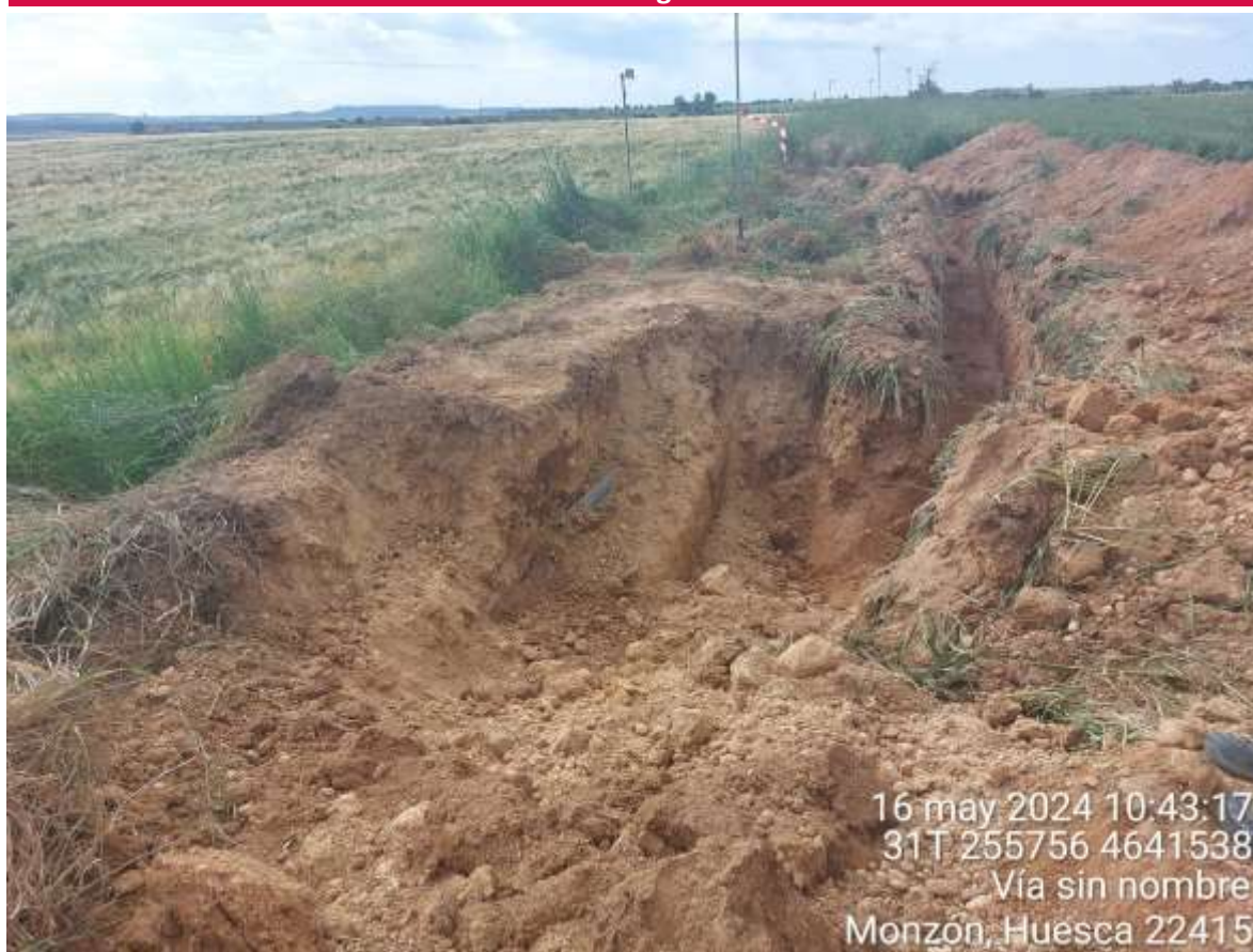
Imagen 1. Trabajos de excavación en el apoyo 31.
