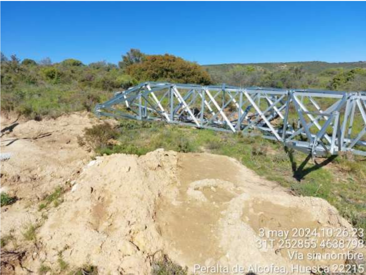
Imagen 1. Apoyo de LAT SC1 pendiente de izado.
