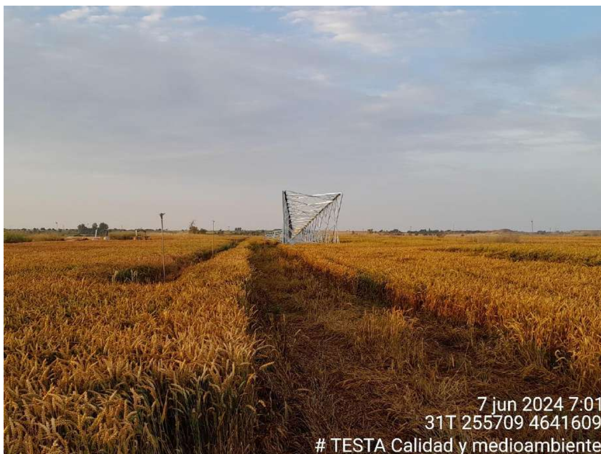
Imagen 1. Apoyo de la LAT SC1
