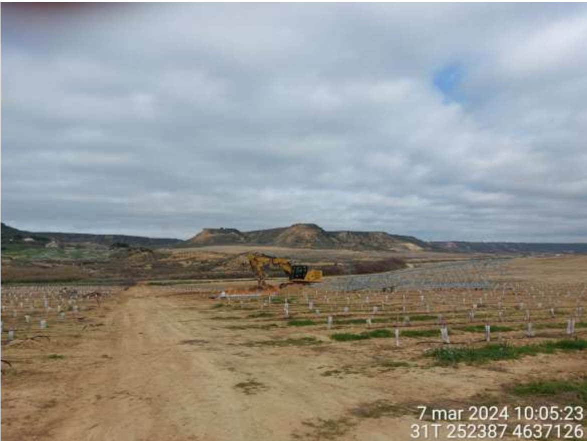
Imagen 1. Maquinaria trabajando en apoyo 10.
