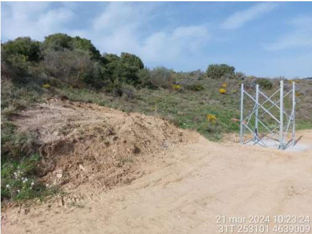
Imagen 2. Apoyo 17 tras hormigonado.
