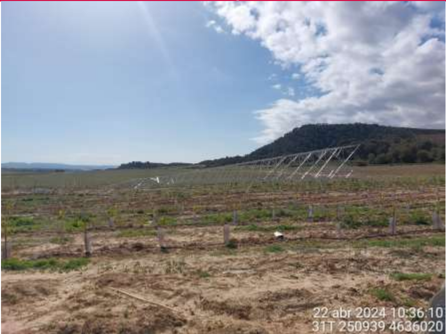
Imagen 1. Apoyo de LAT SC1 sin montar.
