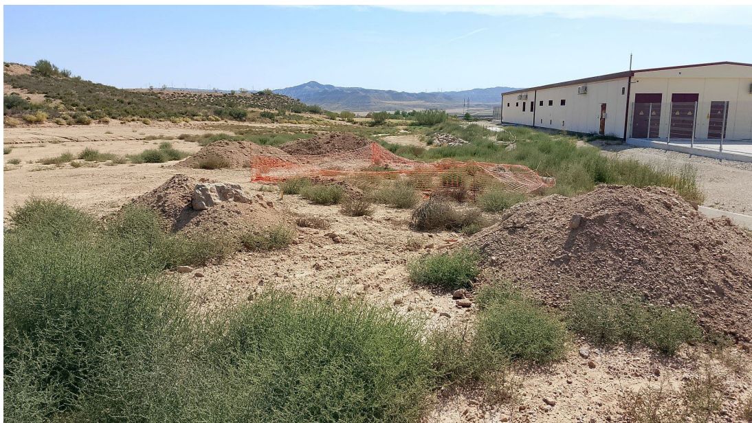
Fotografía 1. Zona de enclave del punto 1 con la zona de excavación balizada y con vista a los acopios del material excavado.
