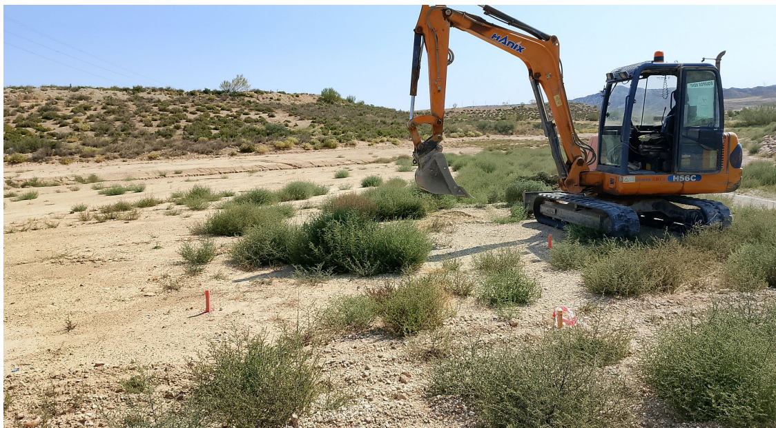
Fotografía 3. Maquinaria junto al punto 1 antes de comenzar la excavación
