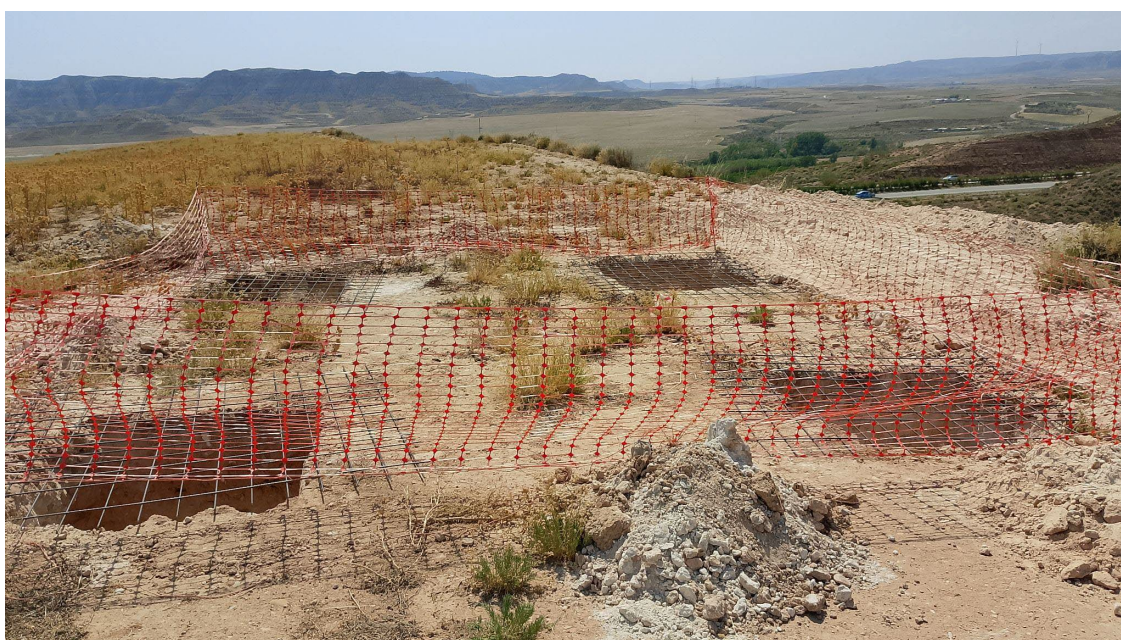
Fotografía 4. Vista a la zona de excavación en el punto 5, con los acopios de tierra vegetal y con los hoyos protegidos con malla metálica
