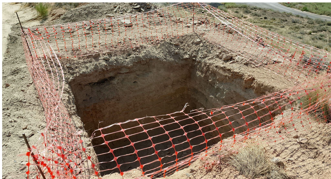
Fotografía 2. Zona excavada en el punto 4, donde se ha dispuesto la tierra excavada para solventar la pendiente y trabajar con más seguridad con la maquinaria
