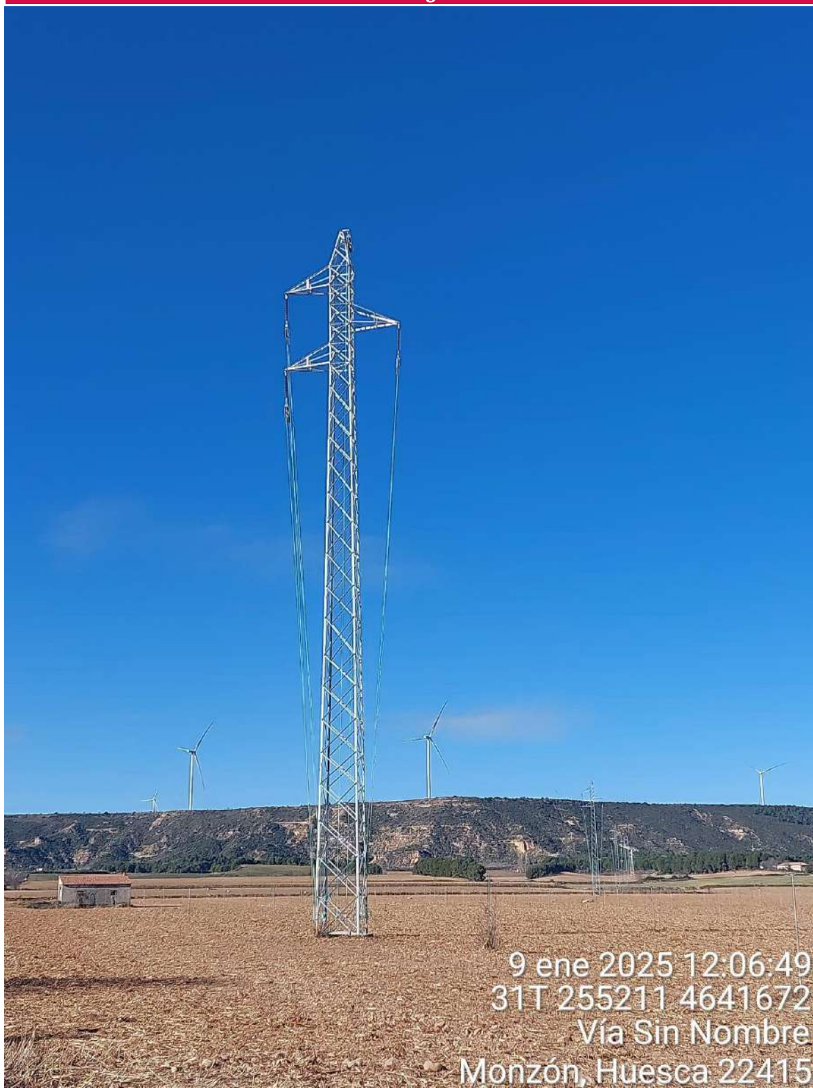
Imagen 1. Apoyos de LAT SC4 con el cable dispuesto para ser tendido.
