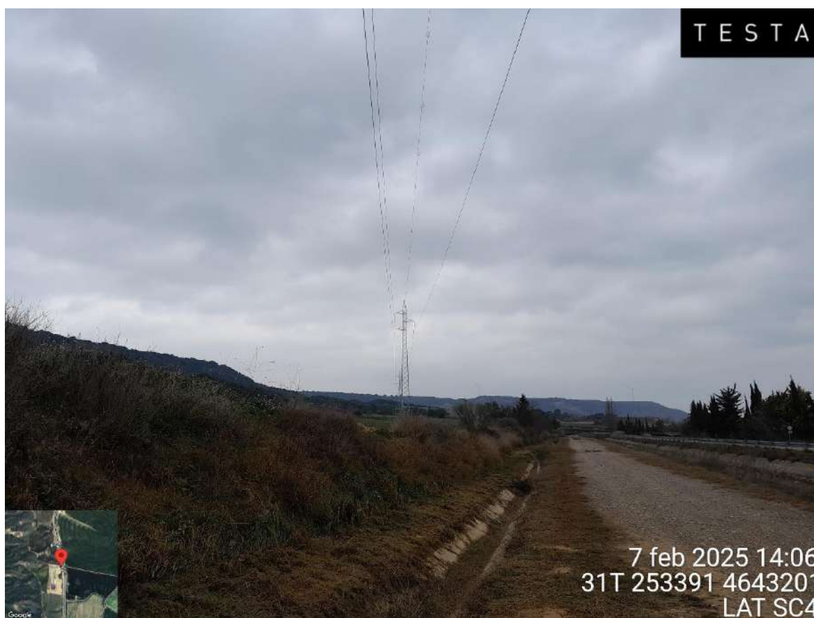
Imagen 1. Tirada de cable, en los apoyos de la LAT SC4
