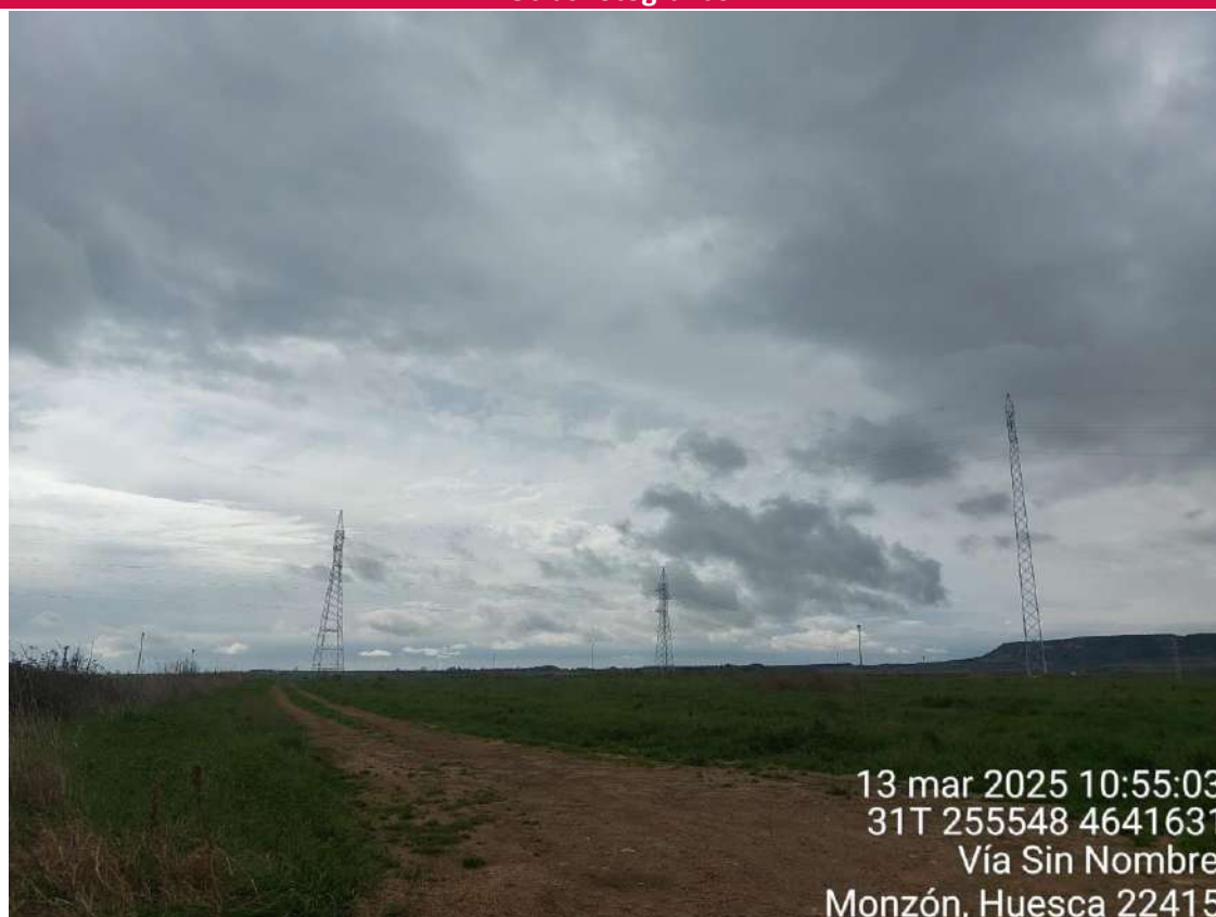
Imagen 1. Apoyo en el que se une LAT SC1 y LAT SC4, ambas con el tendido de cable y los salvapájaros instalados.
