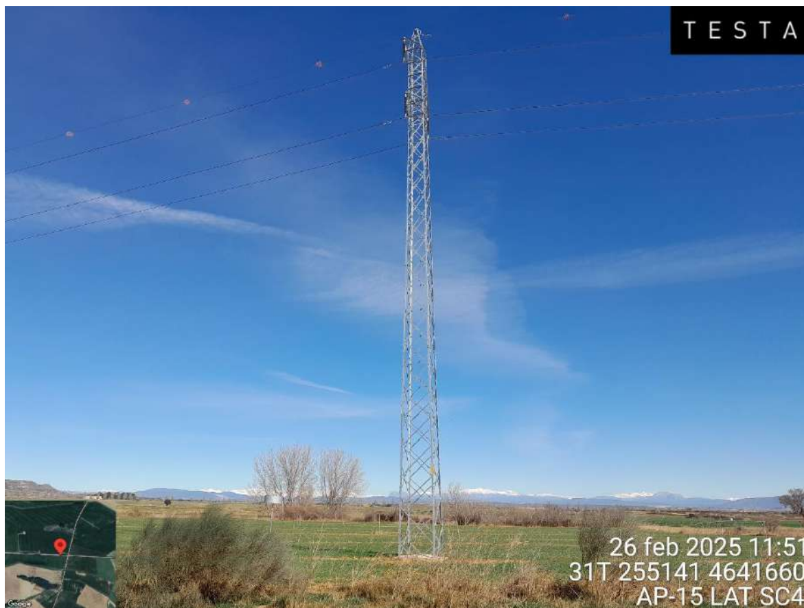
Imagen 1. Apoyo 15 de la LAT SC4
